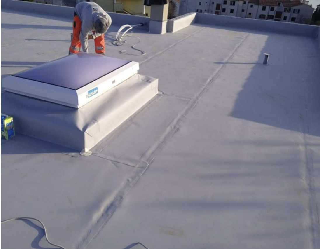
Slika 6: Ugrađena varena TPO membrana (fotografirao autor)
