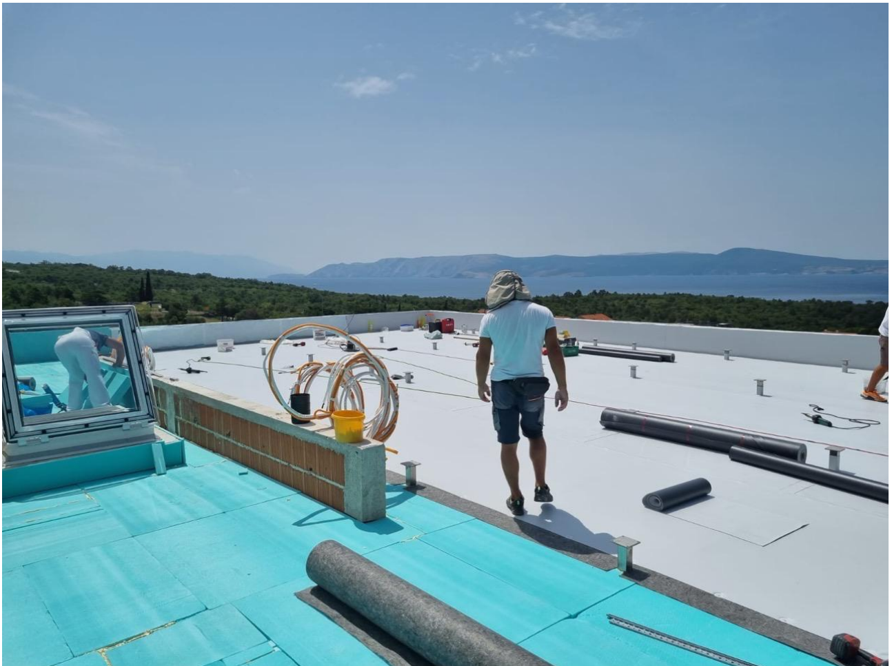
Slika 16: Ugradnja TPO zavarene membrane (fotografirao autor)
