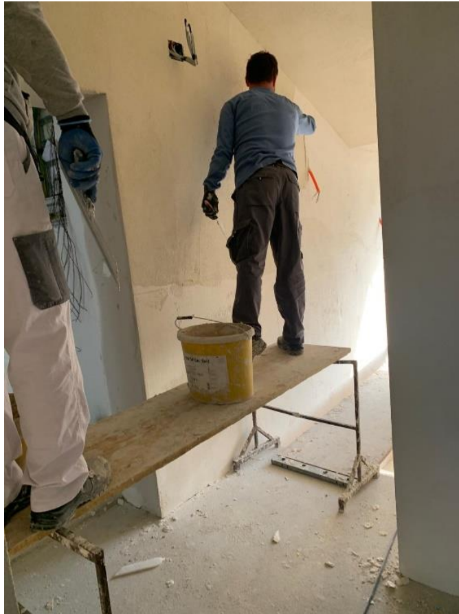
Slika 8: Izvođenje temeljne žbuke u hodnicima zgrade (fotografirao autor)
