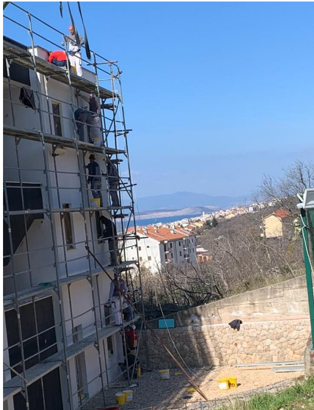
Slika 18: Ugradnja završnog sloja fasade (fotografirao autor)
