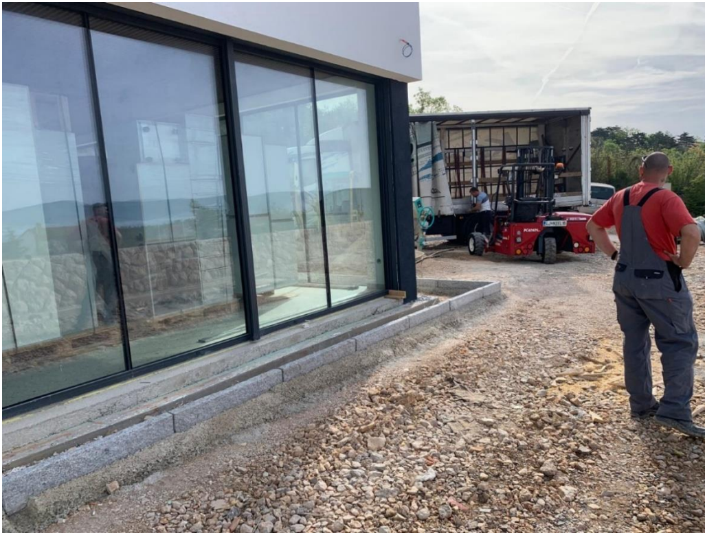
Slika 10: Ugrađeni granitni rubnjaci (fotografirao autor)
