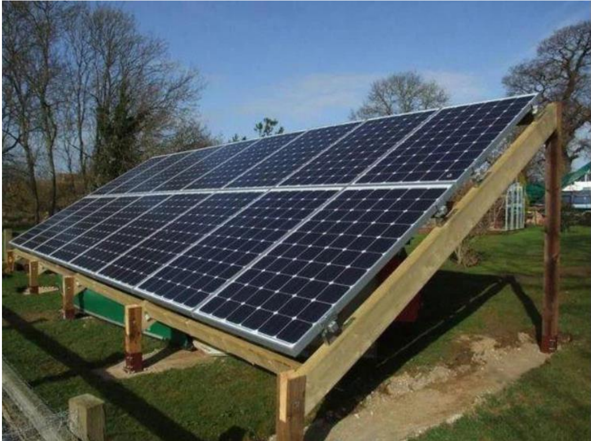
Slika 6: Drvena konstrukcija za pridržavanje solarnih panela [6]
