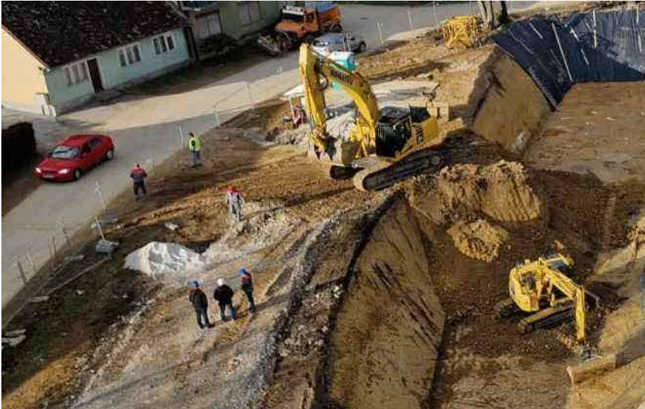
Slika 3. Izvođenje širokog iskopa sa dva bagera
