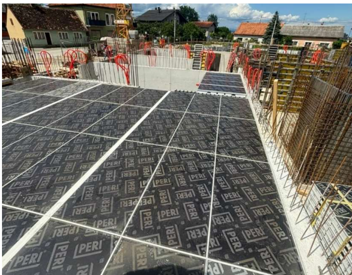
Slika 7. Postavljanje oplatnog sistema "Skydeck" za stropne ploče
