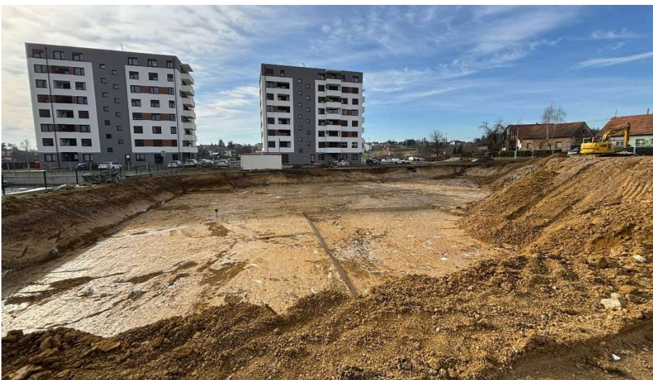
Slika 4. Prikaz materijala širokog iskopa
