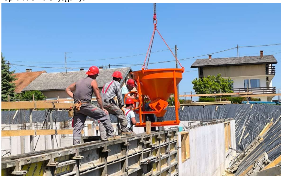
Slika 6. Ugradnja betona iz kible toranjske dizalice
