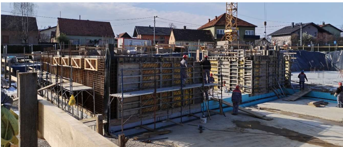
Slika 12. Postavljanje skele oko zidova podruma
