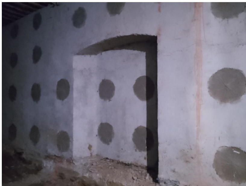
Slika 29 : Zid predmetne građevine ojačan FRCM sustavom (foto autorica, 2023.)
