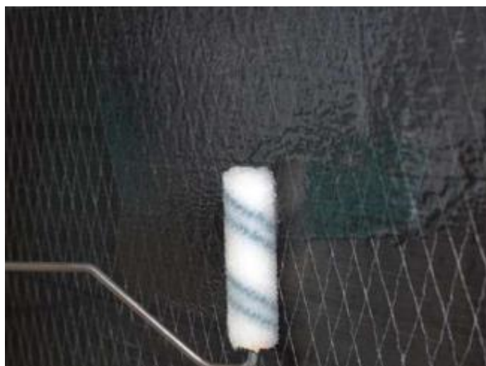
Slika 33: Nanošenje završnog sloja epoksidnog ljepila 75
