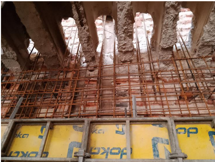
Slika 9 : Postavljena sidra kroz sitnorebričastu međukatnu konstrukciju (foto autorica, 2023.)
