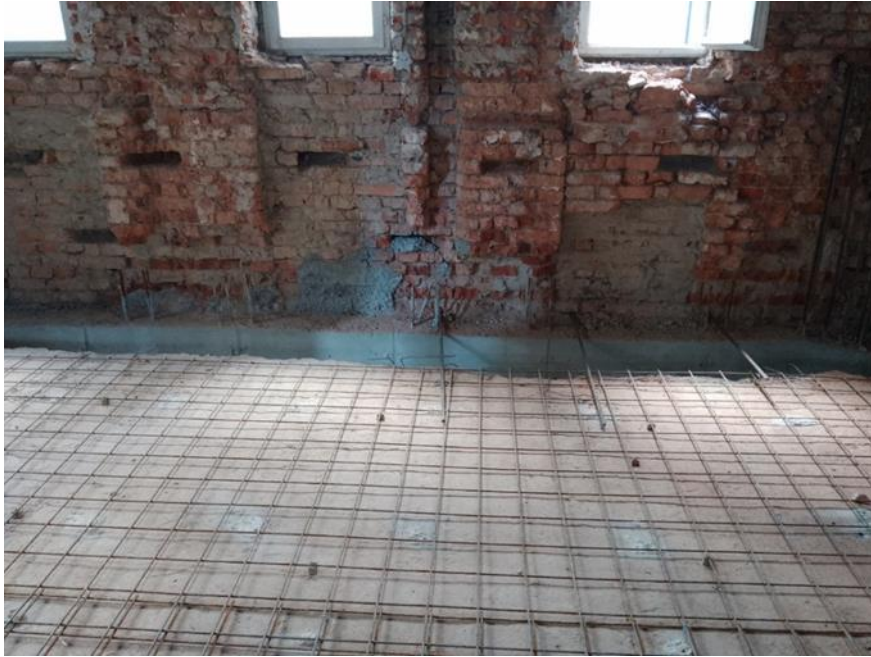
Slika 19 : Postavljena mreža Q-257 na betonskim odstožnicima (foto autorica, 2023.)
