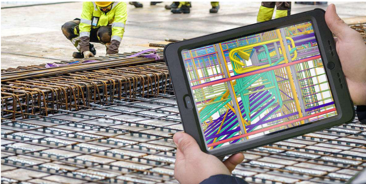
Slika 9: BIM rješenja na gradilištu [6]
