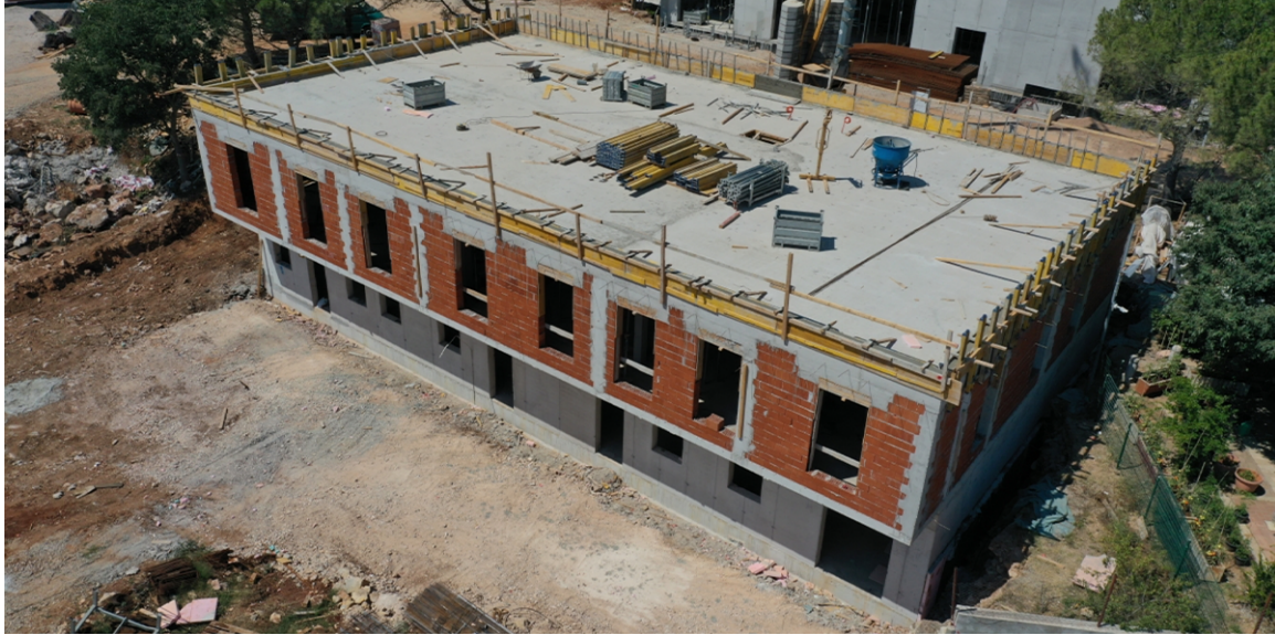
Slika 22 Pogled na Građevinu 3 sa stražnje strane
