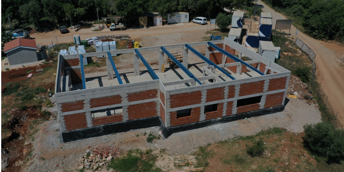
Slika 12 Pogled sa stražnje strane Građevine 1
