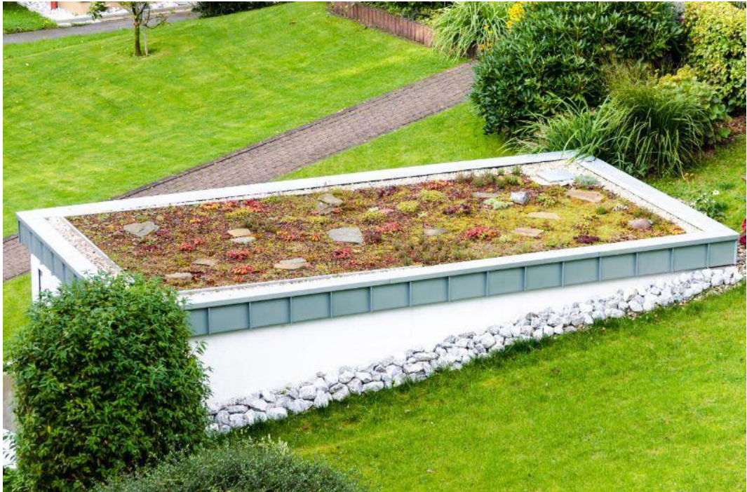
Slika 18: Zeleni krov na garaži [25]
