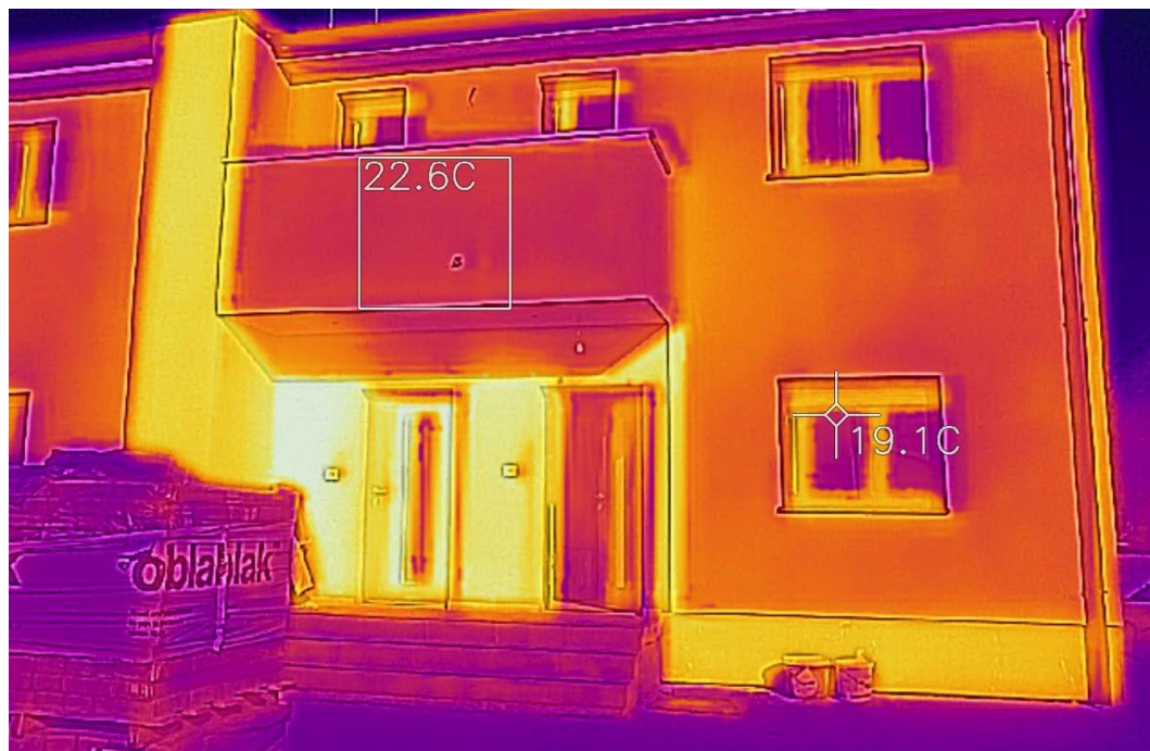
Slika 1: Termografski prikaz toplinskih gubitaka zgrade [27]
