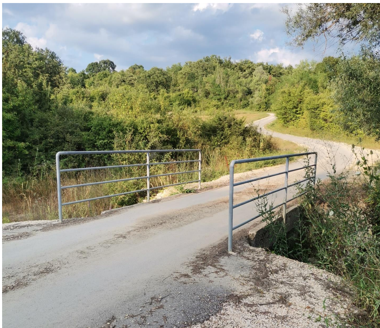
Slika 58: Konstrukcija mosta C i gazna površina mosta i prilaznih staza
