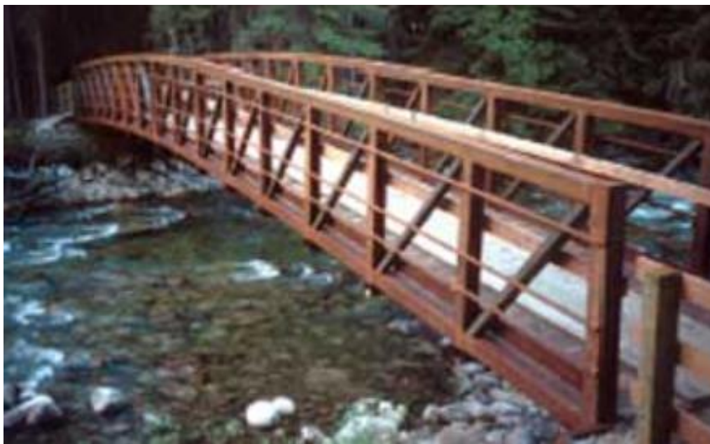
Slika 1: Primjer izvedbe mosta s nagibom do 5% [3]
