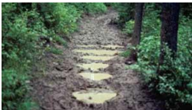
Slika 20: Prikaz stvaranja lokvica i nakupljanja vode na stazi [20]
