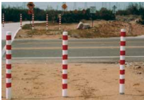
Slika 14: Prikaz postavljanja stupića na ulazu u stazu [18]
