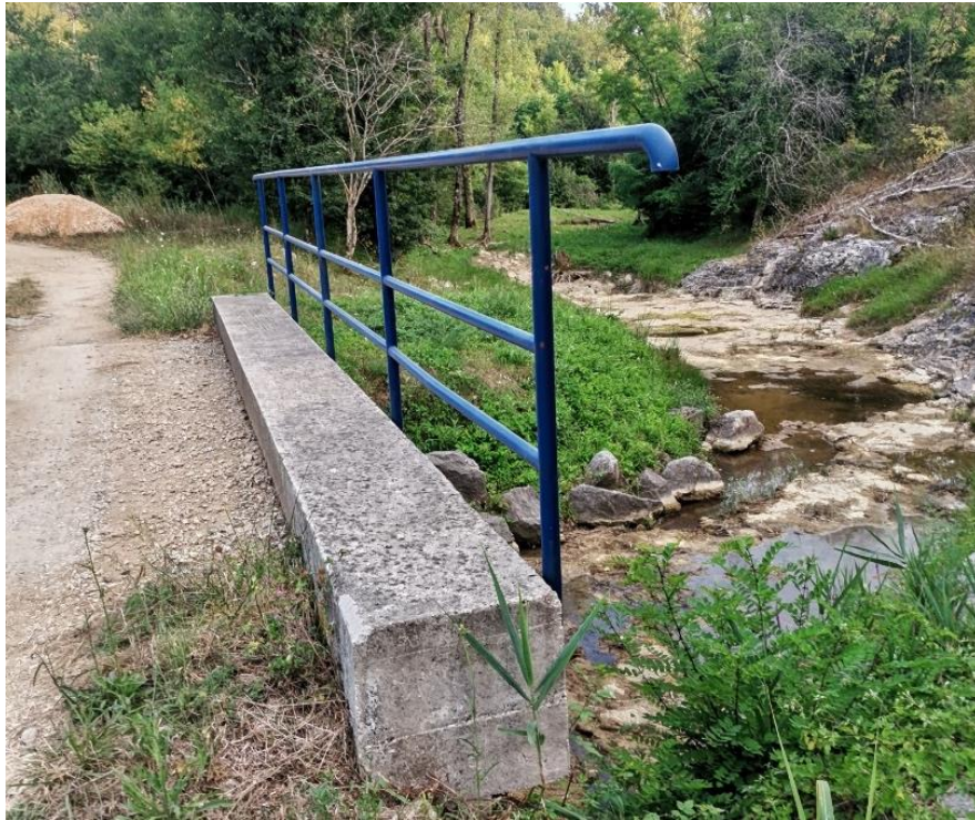
Slika 62: Ograda Mosta D
