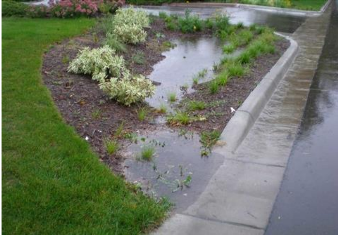
Slika 1: Primjer kišnog vrta koji prikuplja oborinsku vodu s ceste [1].
