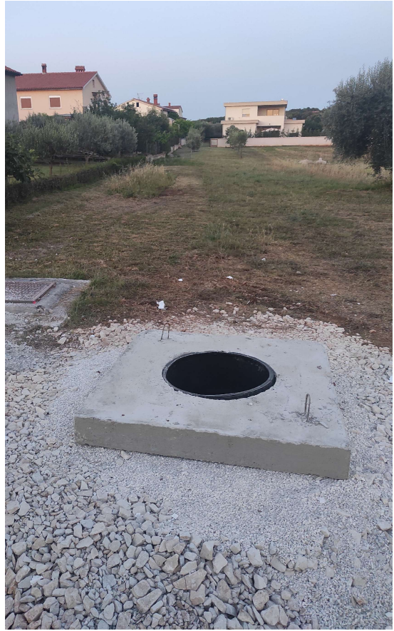
Slika 34: Detalj ugradnje PP okna i rasteretne ploče (autor, 2023)
