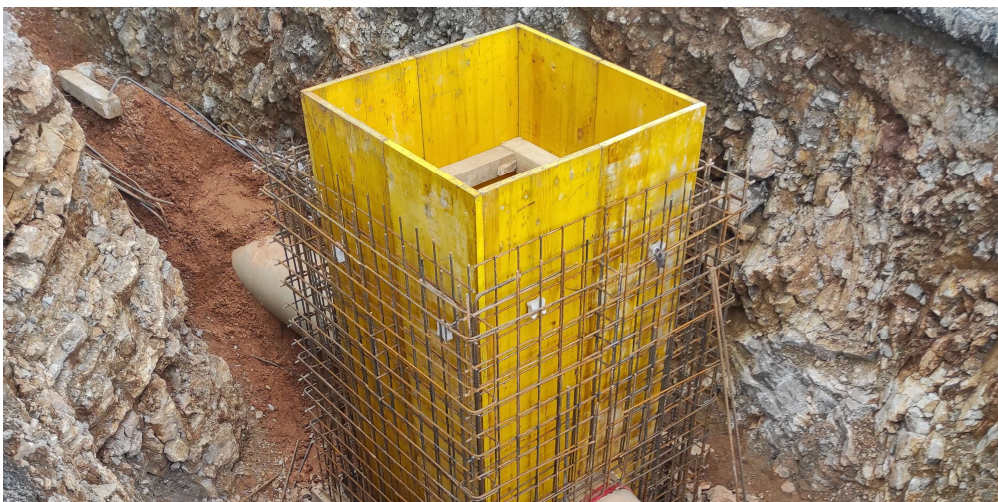
Slika 18: Primjer okna monolitne izvedbe (autor, 2023)
