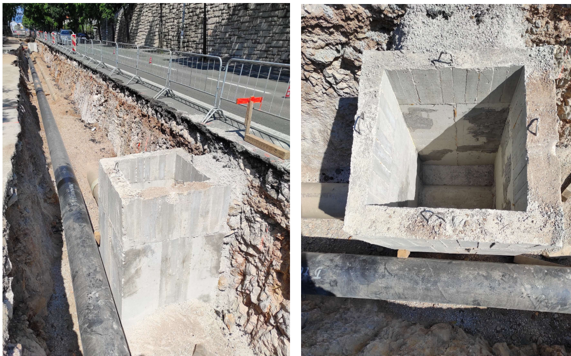
Slika 26: Izvedena armirano-betonska okna (autor, 2024)
