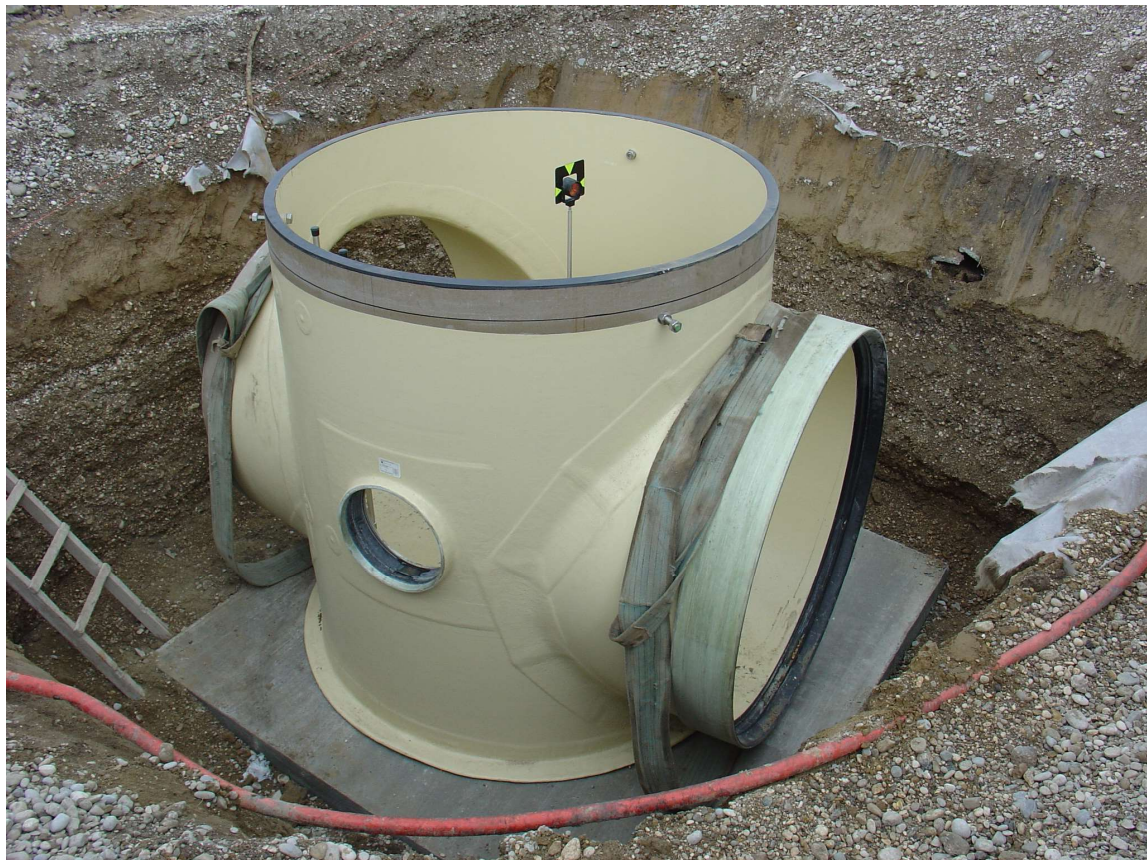
Slika 32: Primjer ugradnje predgotovljenog GRP okna [15]
