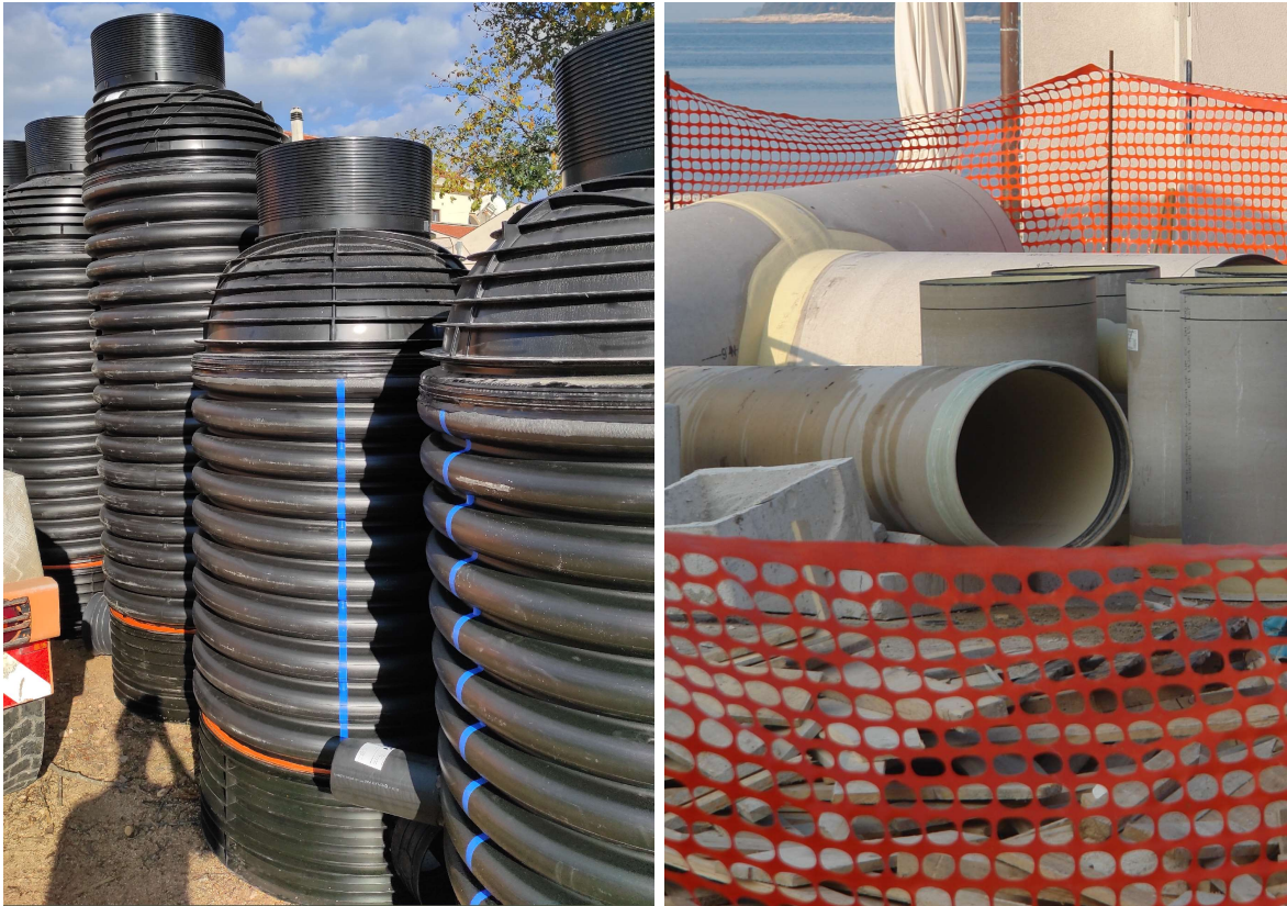
Slika 19: Primjer okna montažne izvedbe - od plastičnih materijala (PP i GRP) (autor 2007, 2023)
