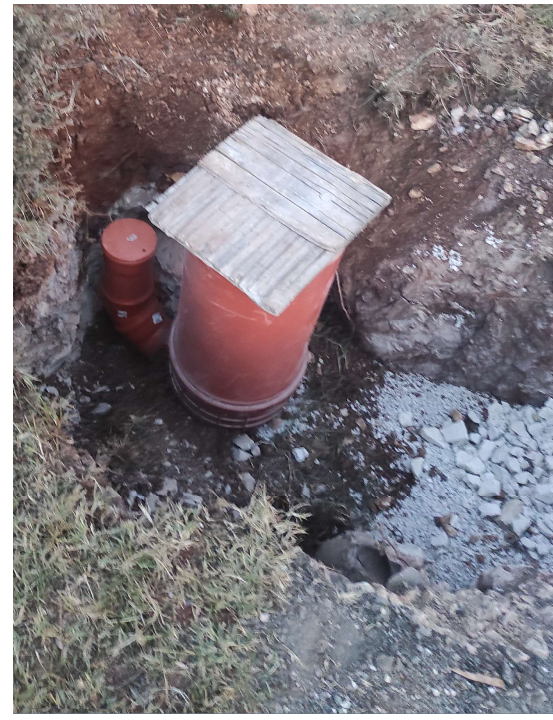
Slika 35: Detalj priključnog PVC okna DN 400 mm (autor, 2023)
