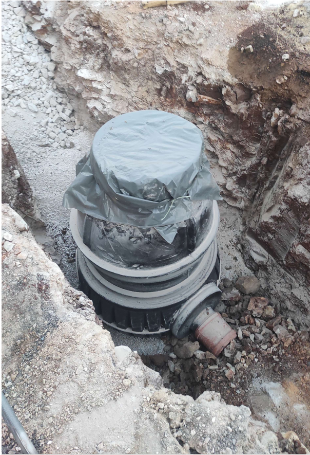
Slika 34: Detalj ugradnje PP okna i rasteretne ploče (autor, 2023)
