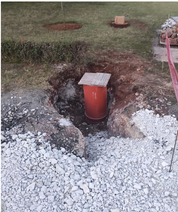
Slika 35: Detalj priključnog PVC okna DN 400 mm (autor, 2023)
