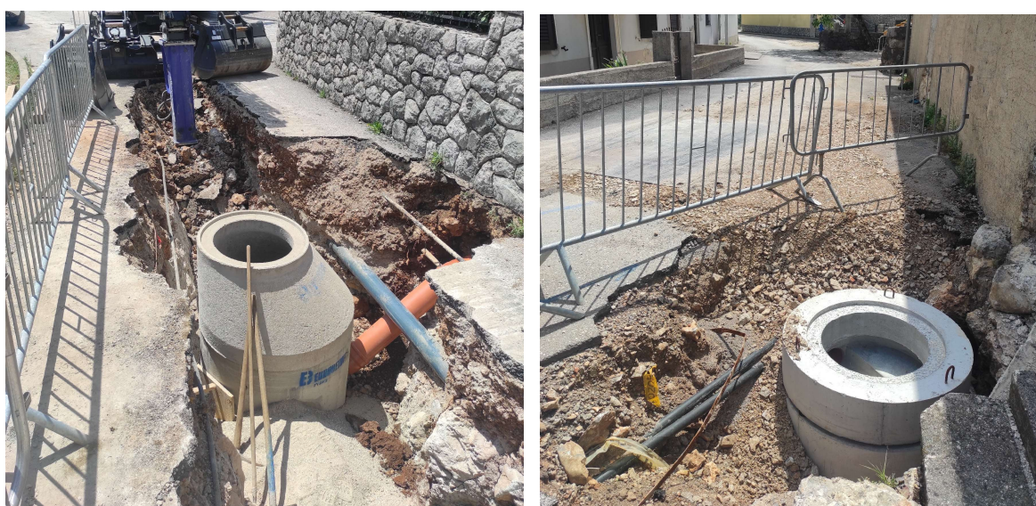
Slika 30: Primjer ugradnje predgotovljenog betonskog okna (autor, 2024)
