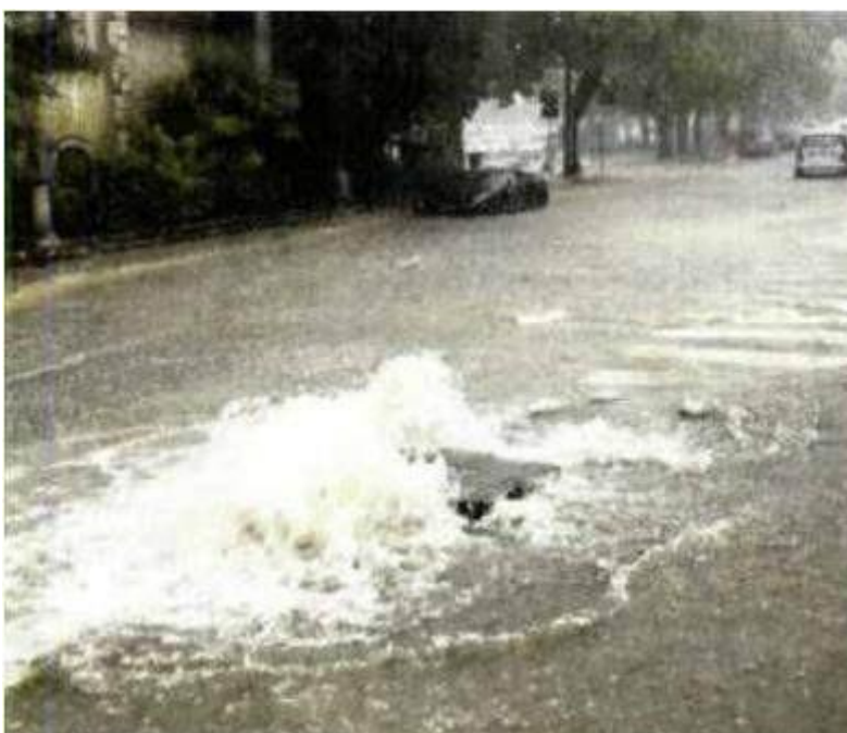
Slika 7. Izbijanje oborinske vode iz šahta [7]
