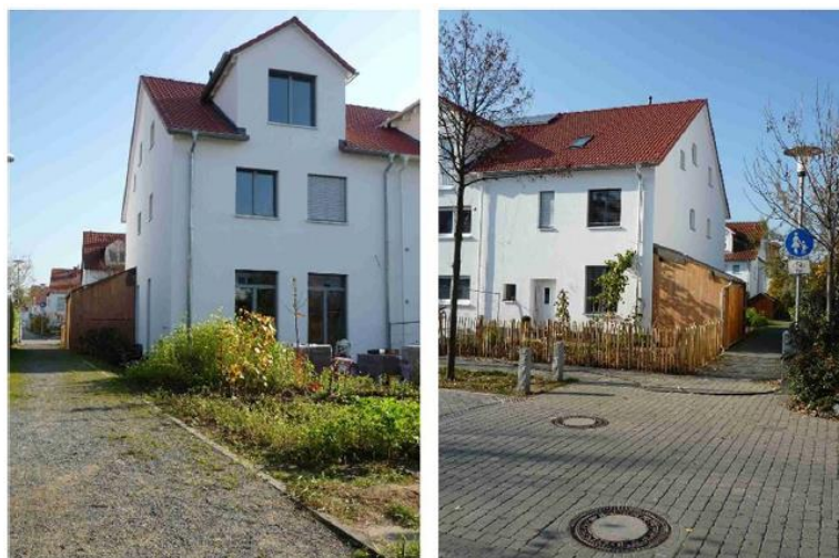
Slika 27. Pasivna zgrada u Darmstadtu [27]
