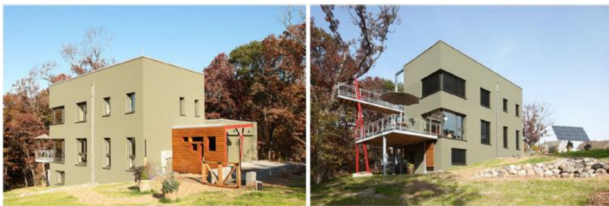
Slika 23. Obiteljska kuća u Hudsonu [27]
