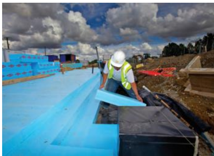
Slika 13. Postavljanje izolacije ispod podne ploče [9]
