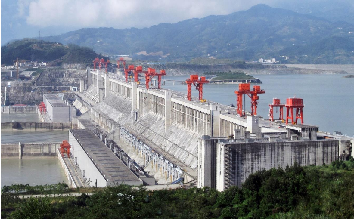
Slika 24: Hidroelektrana u Kini na rijeci Jangce: Tri klanca [4]
