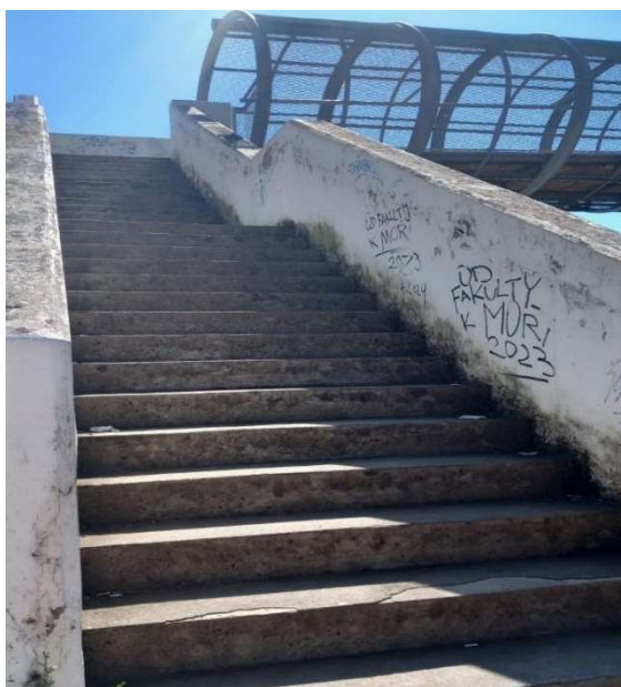
Slika 71: Stubište i betonska ograda [autorica]
