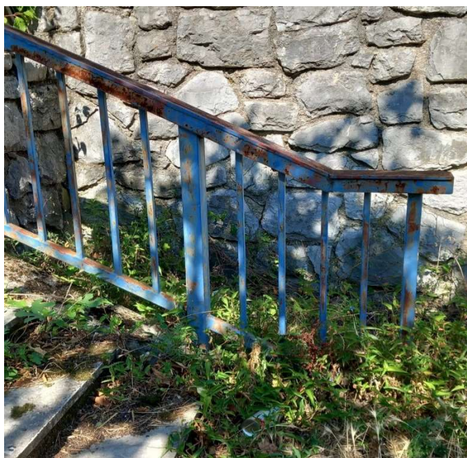
Slika 65: Detalj produljenja ograde i rukohvata od ruba prve stube [autorica]
