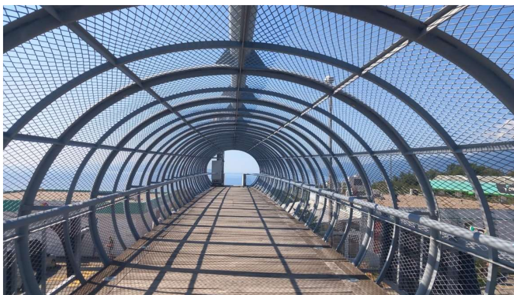
Slika 68: Elipsoidni čelični prstenovi i mreža od istegnutog lima [autorica]
