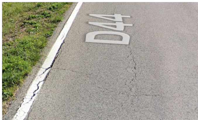
Slika 23. Deformacije na rubu kolnika [Google karte]
