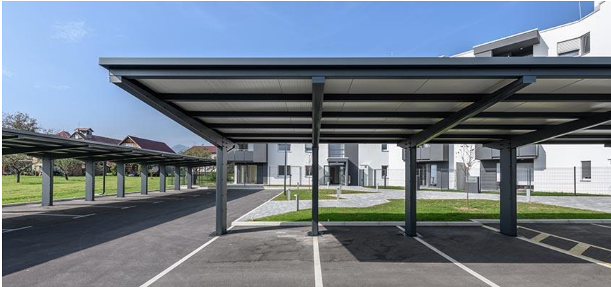
Slika 1: Konzolna metalna nadstrešnica [4]
