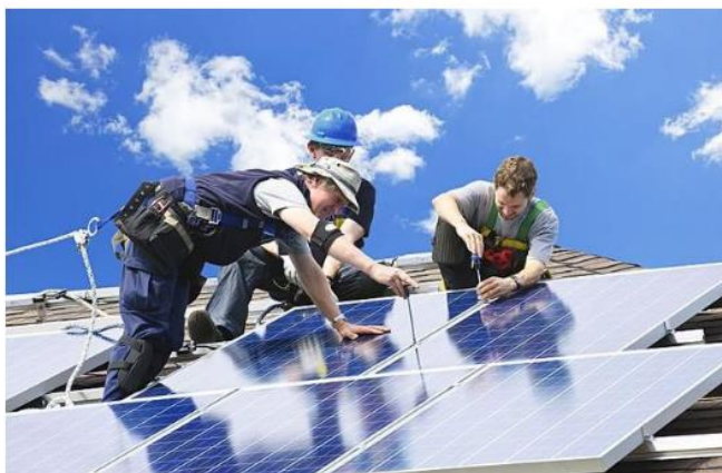
Slika 1: Ugradnja solarnih panela na krov konstrukcije [3]
