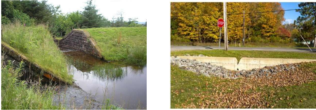
Slika 8. Primjeri preljeva retencije [27,28].
