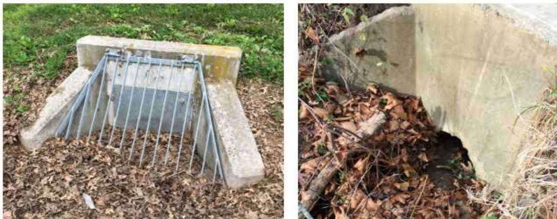
Slika 5. Prikaz onečišćenog ispusta u detenciji [19].
