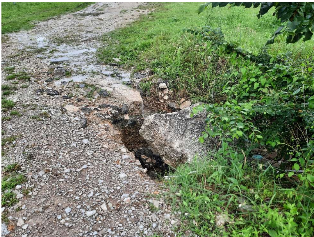
Slika 26. Prikaz sadašnjeg stanja pražnjenja infiltracijske površine [45].
