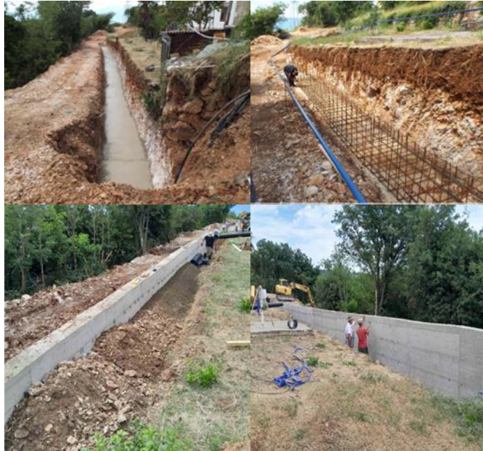
Slika 9. Izrada armiranobetonskog L zida na projektu Aglomeracija - Drenova u etapama [Autor: Tea Mlinarić,2023.]
