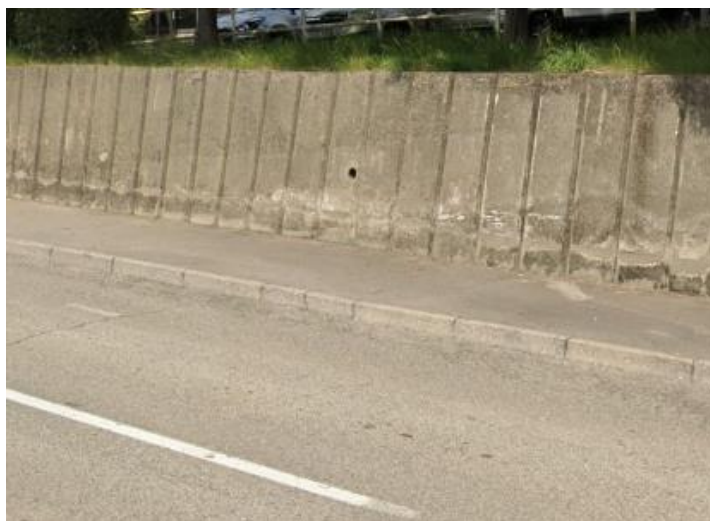
Slika 4. Primjer betonskog potpornog zida [foto-autor]
