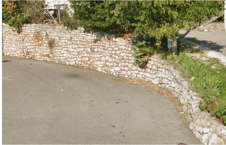
Slika 3. Primjer potpornog zida izrađenog od kamena [foto-autor]
