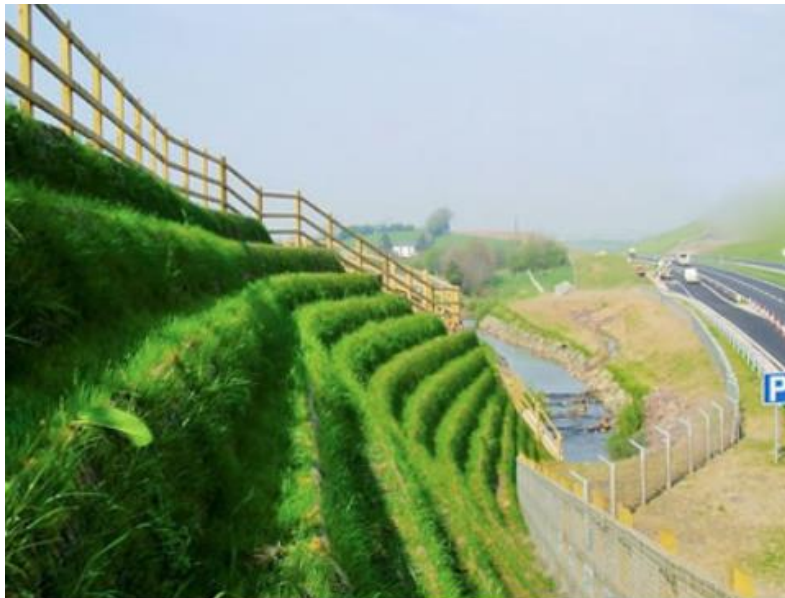
Slika 15. Gabionski zid ozelenjen vegetacijom [13]
