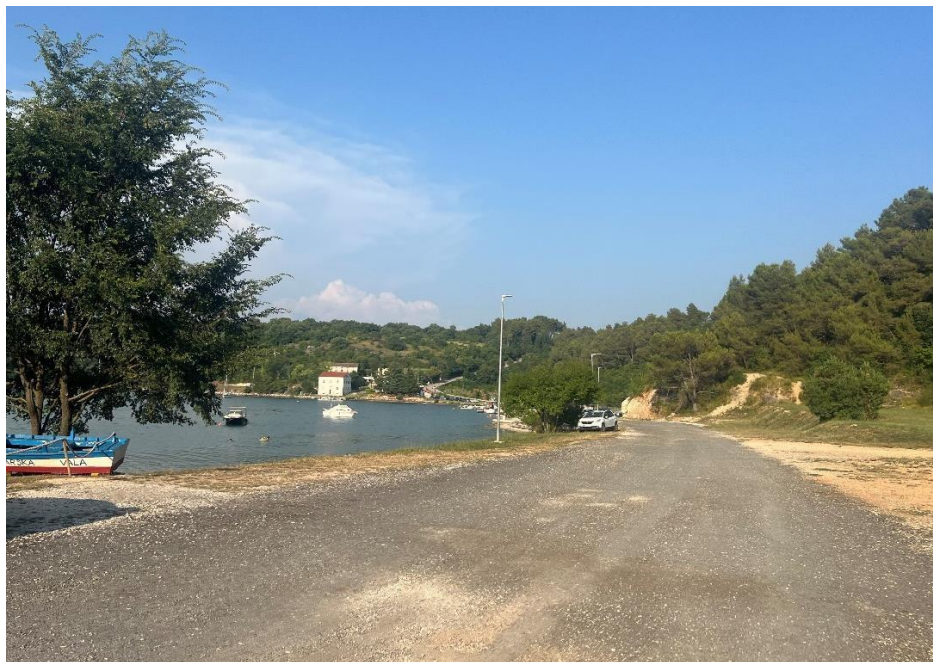
Slika br. 5, Neasfaltirana prometnica uz obuhvat (izvor: autor)
