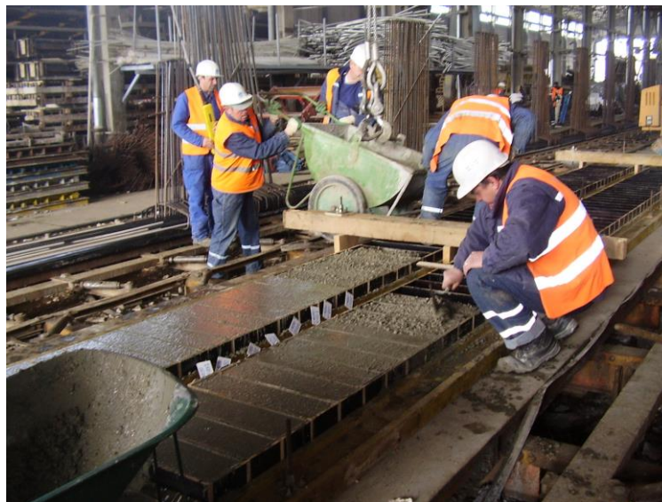
Slika 3.12 Betoniranje kalupa za statičko ispitivanje greda na savijanje pod kontrolom pomaka
