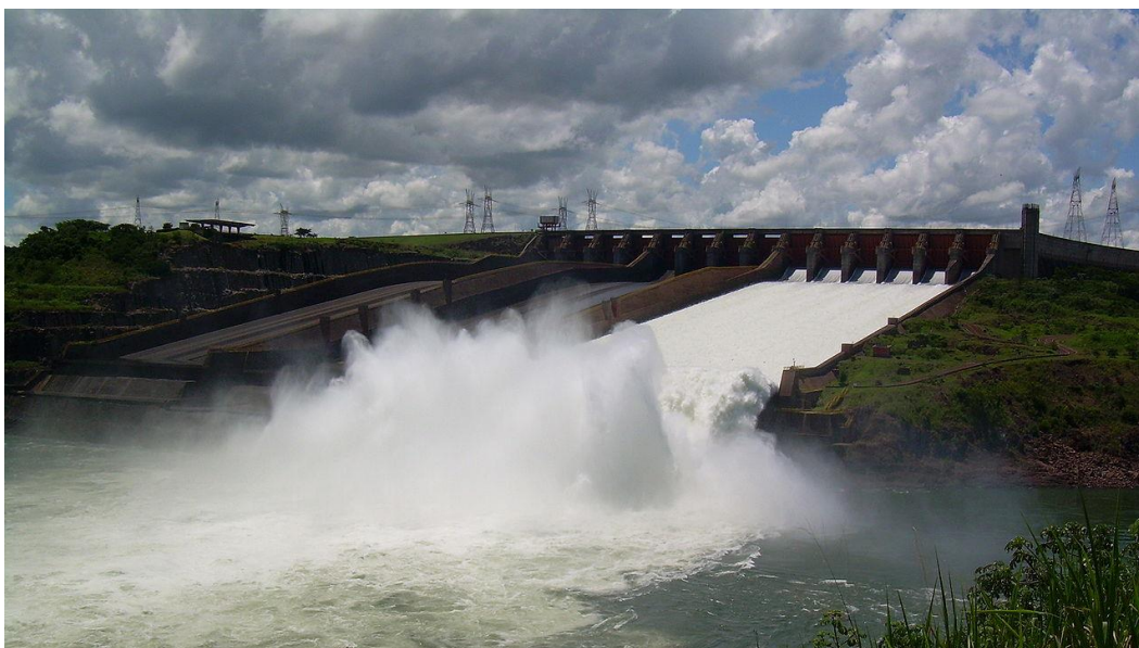
Slika 2: Betonska brana Itaipu u Brazilu [3]
