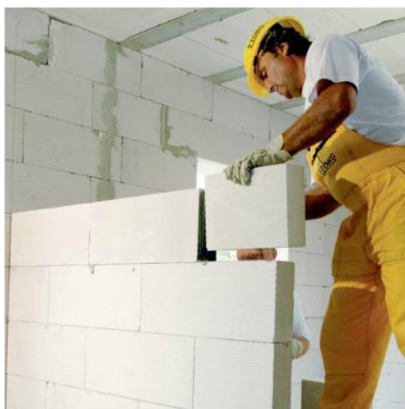
Slika 7: Zidanje pregradnog zida Ytong blokovima [8]
