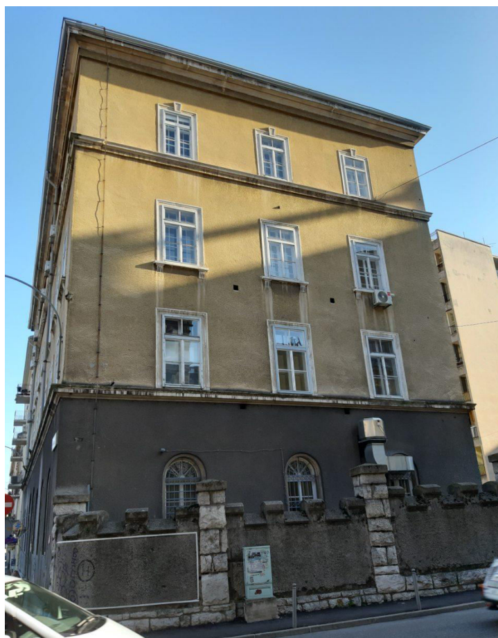
Slika 55. Sjeverozapadno pročelje Narodnog učilišta
