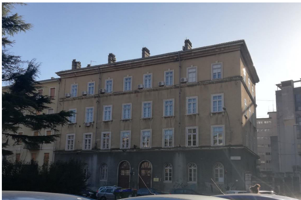
Slika 54. Sjeveroistočno pročelje Narodnog učilišta
