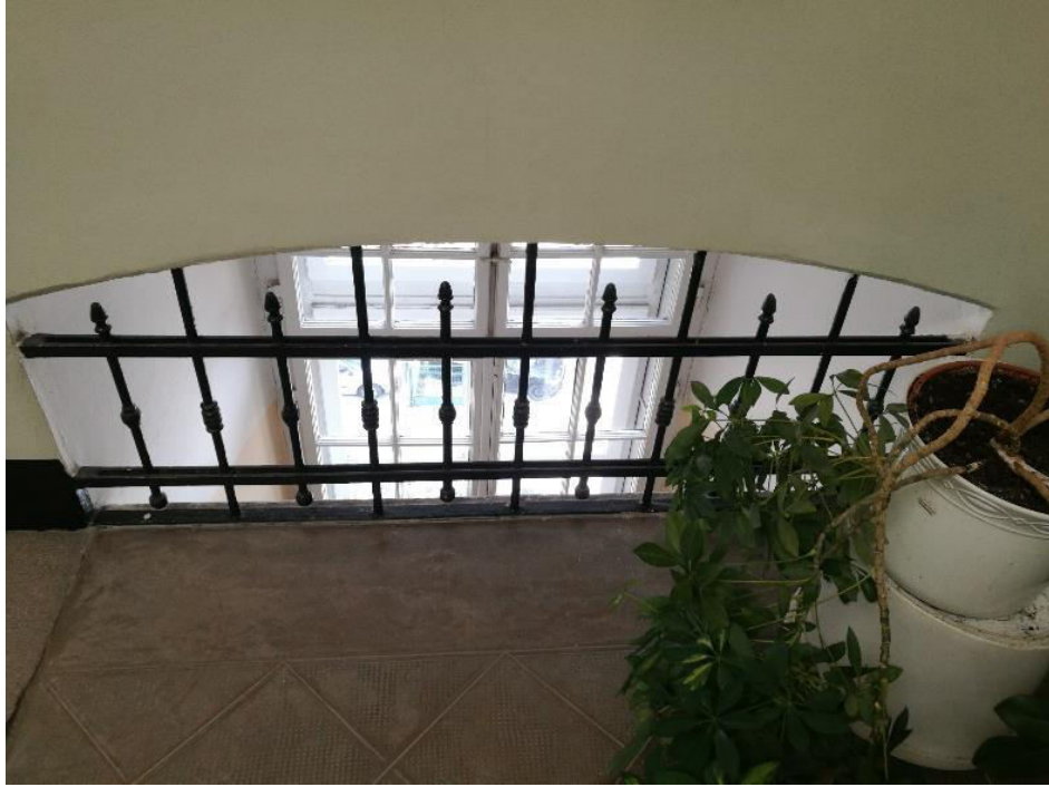
Slika 76. Metalna rešetka na dijelu podesta gdje se nalazi prozor
