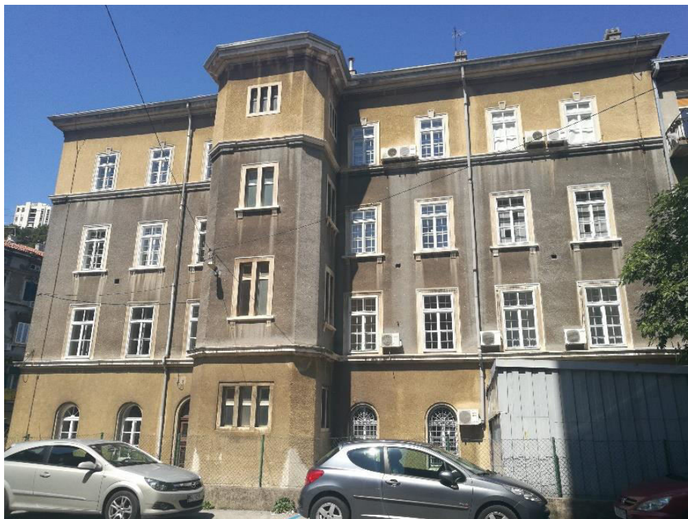
Slika 56. Jugozapadno pročelje Narodnog učilišta
