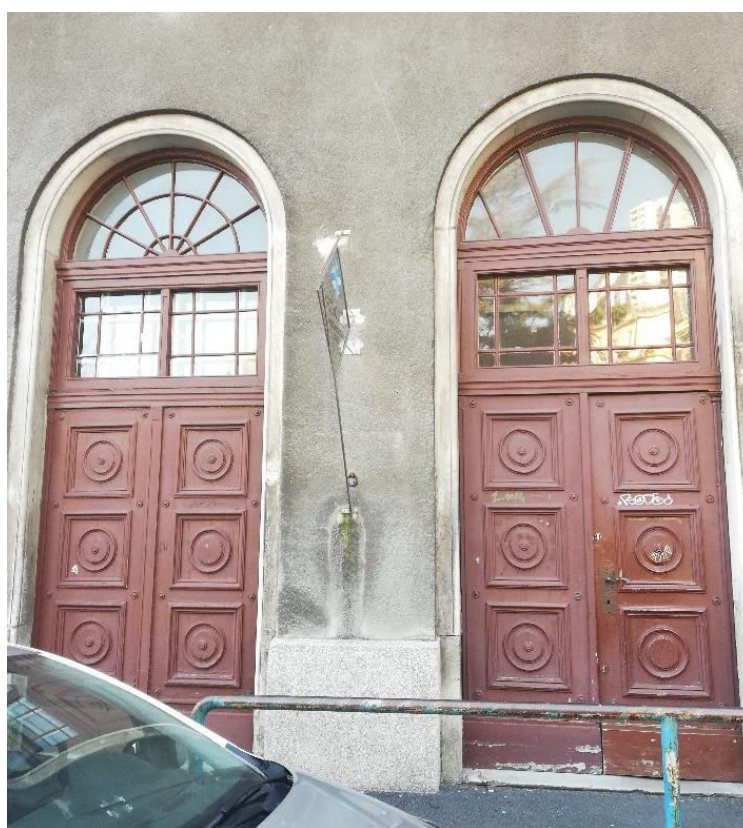
Slika 57. Ulazna vrata na sjeveroistočnom pročelju Narodnog učilišta
