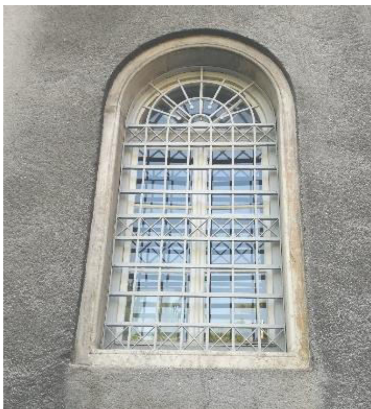
Slika 59. Prozor sjeverozapadnog pročelja s metalnom rešetkom
