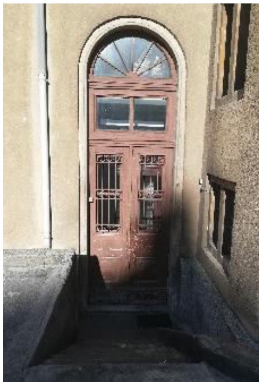
Slika 58. Ulazna vrata na jugozapadnom pročelju
