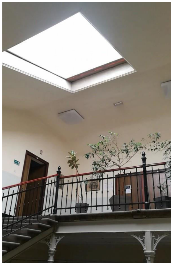
Slika 81. Krovni prozor nad stubištem
