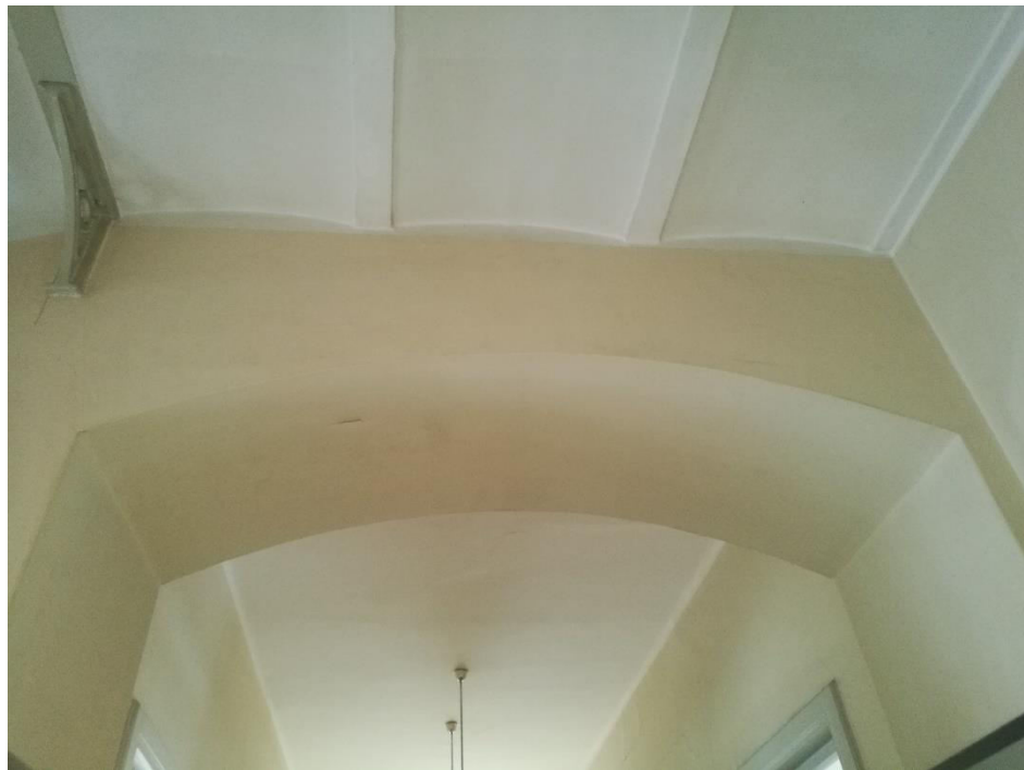
Slika 77. Pogled stropa – pruski svod
