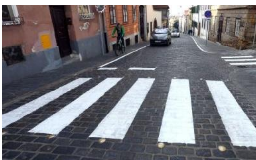
Slika 17. Pješački prijelaz s ugrađenim katadiopterima [16]
