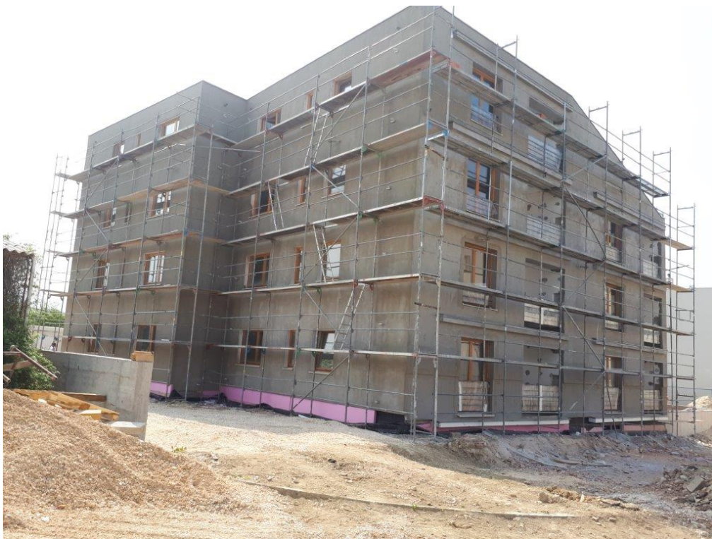
Slika 17: Sjeverozapadno pročelje za vrijeme građenja
