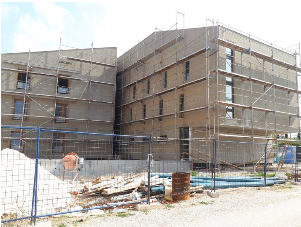
Slika 15: Jugozapadno pročelje za vrijeme građenja
