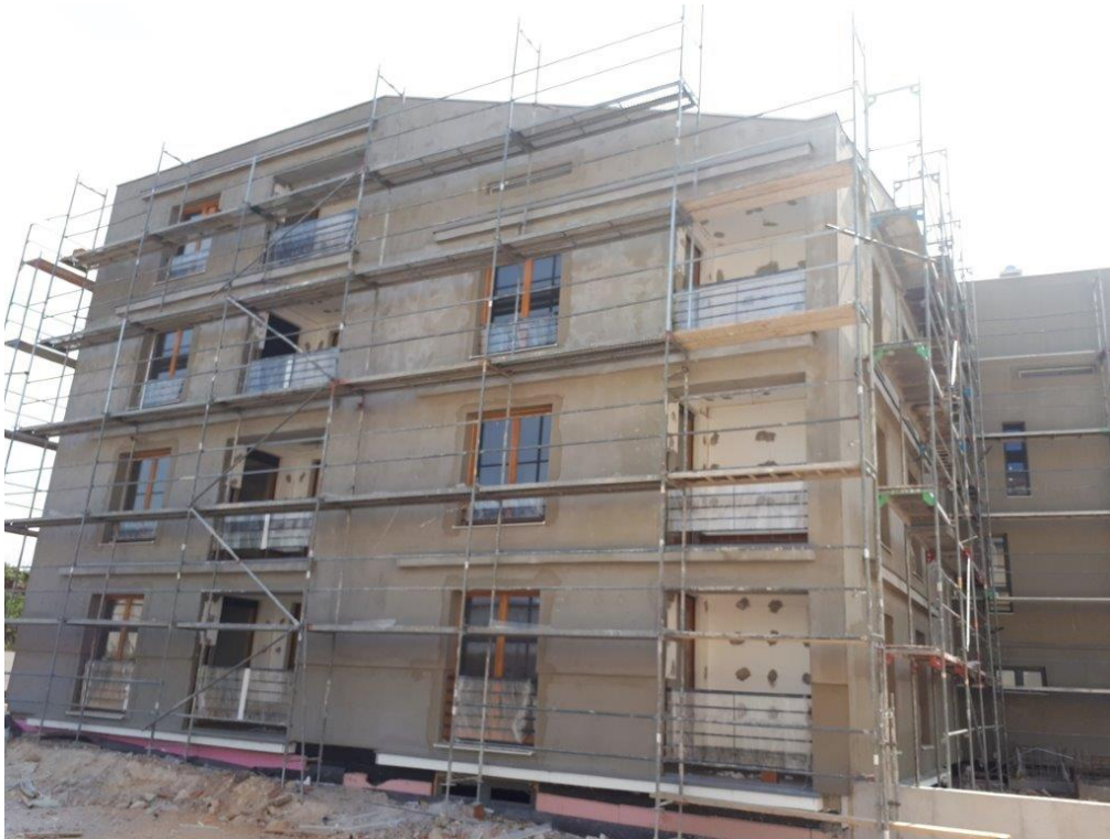
Slika 16: Sjeveroistočno pročelje za vrijeme građenja
