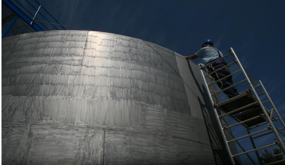
Slika 33. Radovi održavanja (Rac, 2019.)
