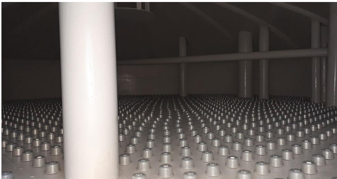
Slika 31. Sapnice unutar samoisperivog gravitacijskog pješčanog filtera (Rac, 2019.)
