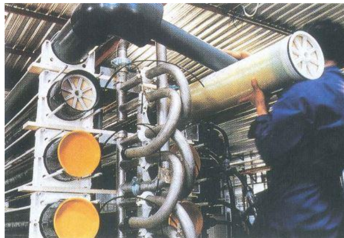
Slika 20. Postrojenje nanofiltracije (Gulić, 2003.)
