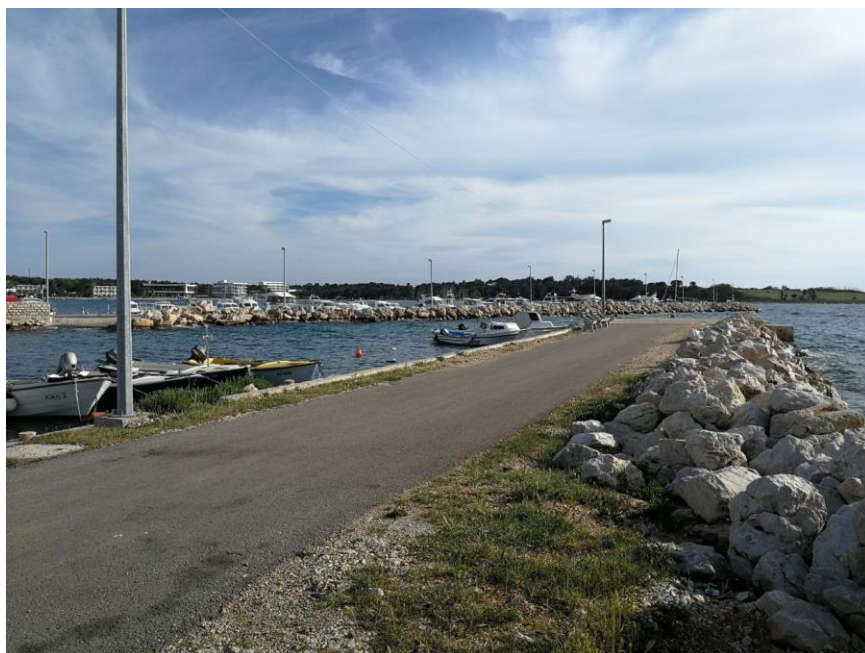
Slika 5. Pogled na južni lukobran (foto autor)
