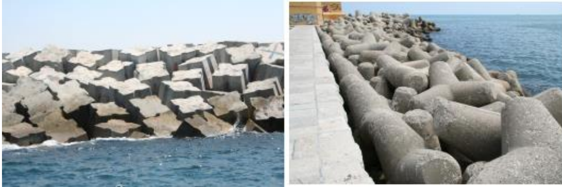
Slika 9: Lukobran obložen antiferima (lijevo) i tetrapodima (desno) [1]
