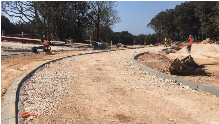
Slika 9: Ugradnja tamponskog sloja
