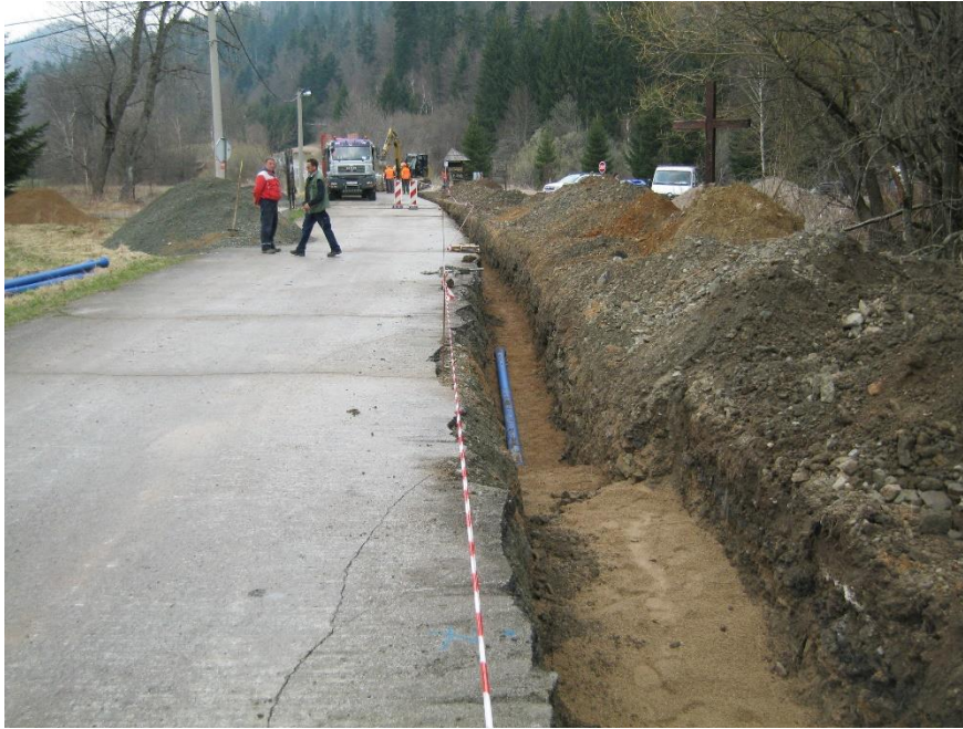
Slika 7: Zatrpavanje vodovodne cijevi pijeskom 0 - 4 mm
