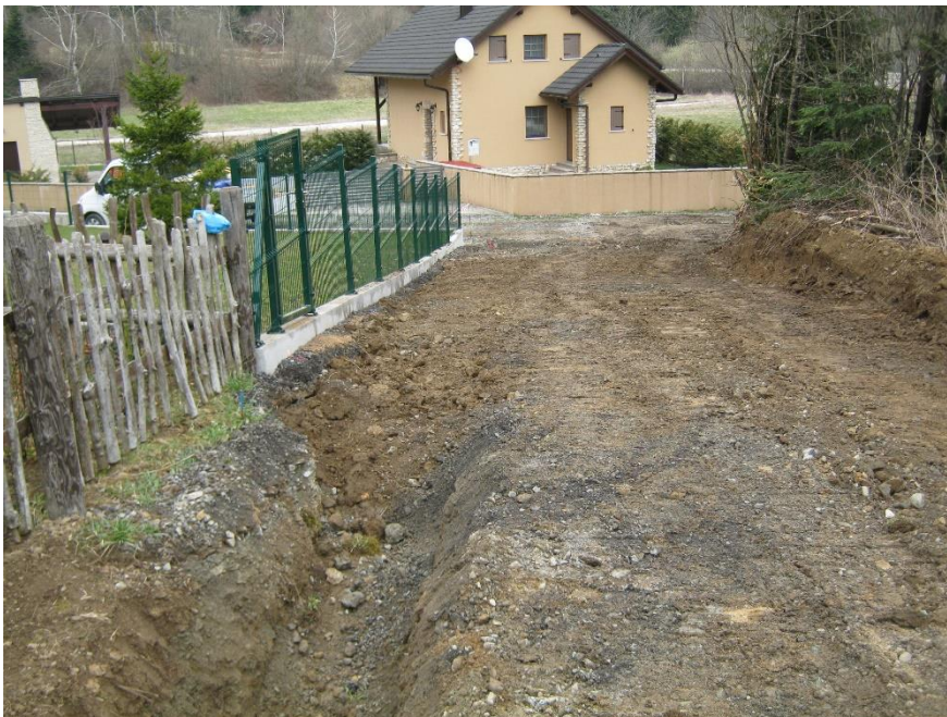
Slika 12: Obnova tucaničkog kolnika kamenim materijalom
