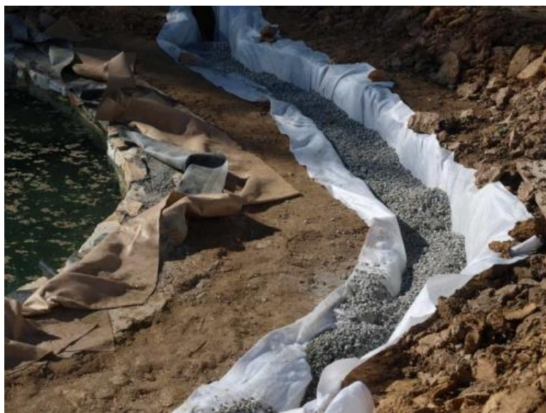
Slika 13: Ugrađeni geotekstil
