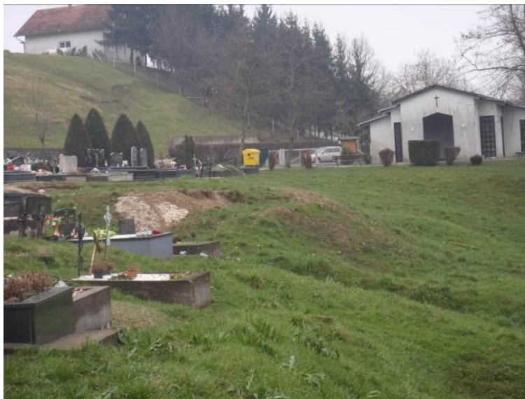
Slika 22. Klizište 1 aktivirano 4. travnja 2013. godine (fotografirano 4.3.2014) – pogled na gornji dio klizišta i oštećene grobove (preuzeto iz Mihalić Arbanas i dr., 2014).
