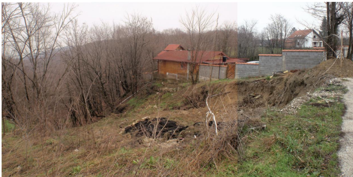
Slika 15. Gornji dio klizišta Galgovo-Zagrebačka (snimljeno 4.3.2014). Vidljiva je kruna klizišta, glavna pukotina, desni bok klizišta. Gornji dio pokrenute mase koji je spušten približno 1,5 m po glavnoj pukotini (preuzeto iz Mihalić Arbanas i dr., 2014).
