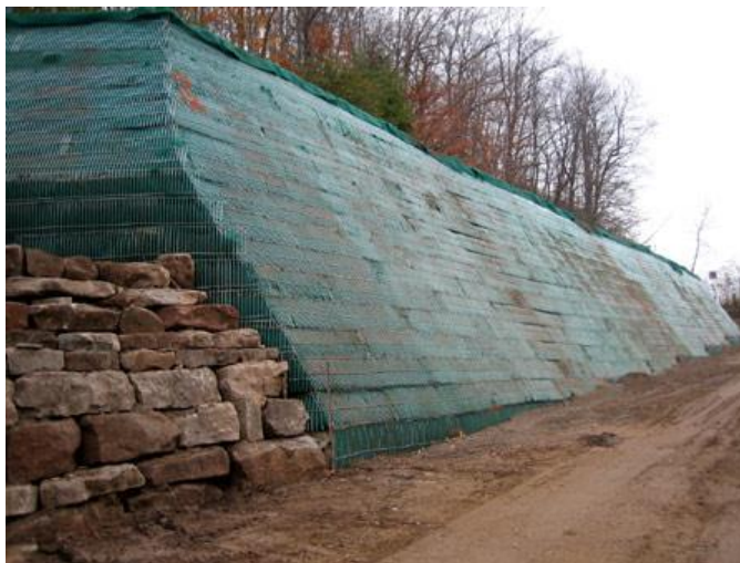
Slika 13: Zid od nasutog materijala ojačan geomrežom [13]
