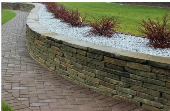
Slika 14 : Zidovi od lomljenog kamena [13]
