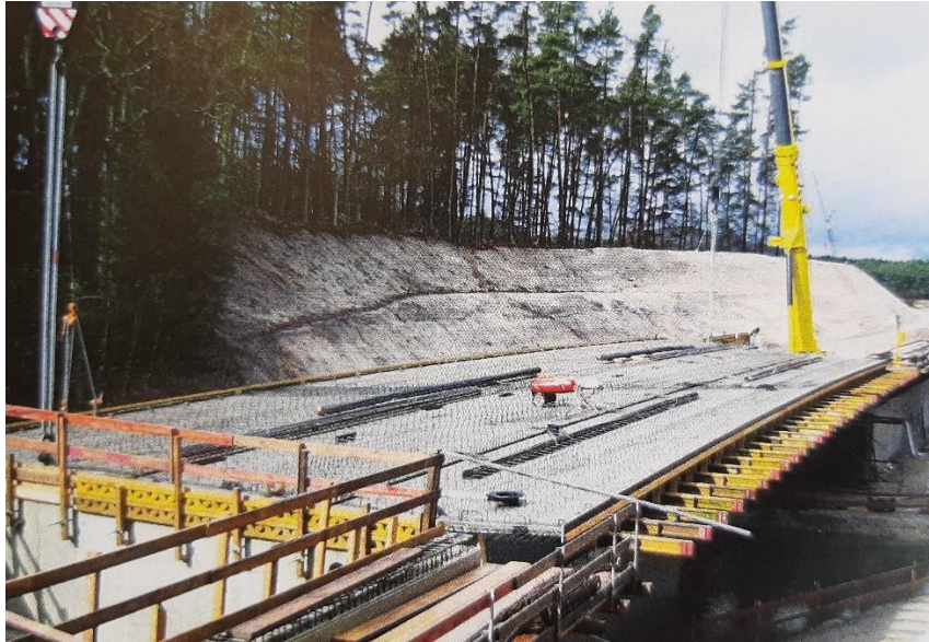
Slika 17. Izvedba mosta na državnoj cesti, Sengenhal [39]
