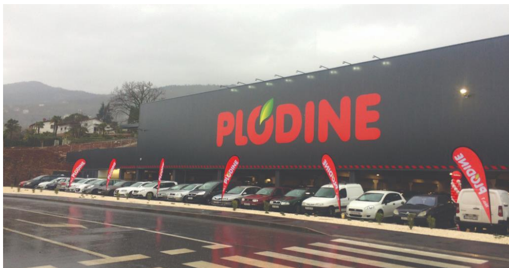
Slika 29. Građevina poslovne namjene - supermarket plodine sa pripadajućom građevnom jamom u pozadini [33]
