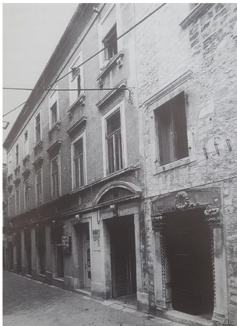
Slika 29: Pogled na kuću Borelli [2]
