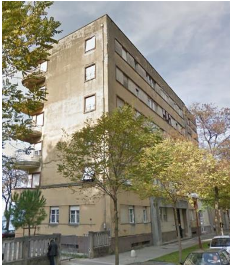
Slika 46: Pogled na stambenu zgradu za gradske službenike [19]
