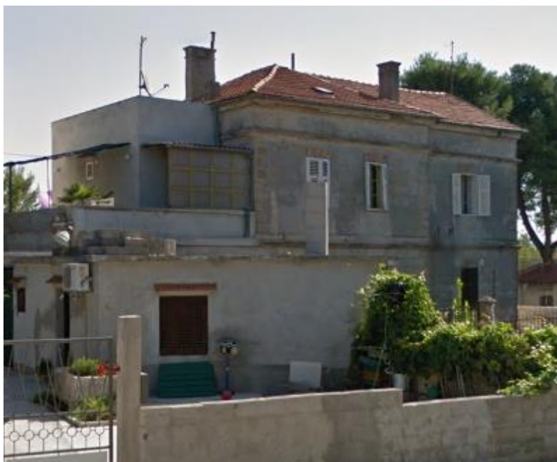
Slika 9: Pogled na kuću Vrbinšak [19]
