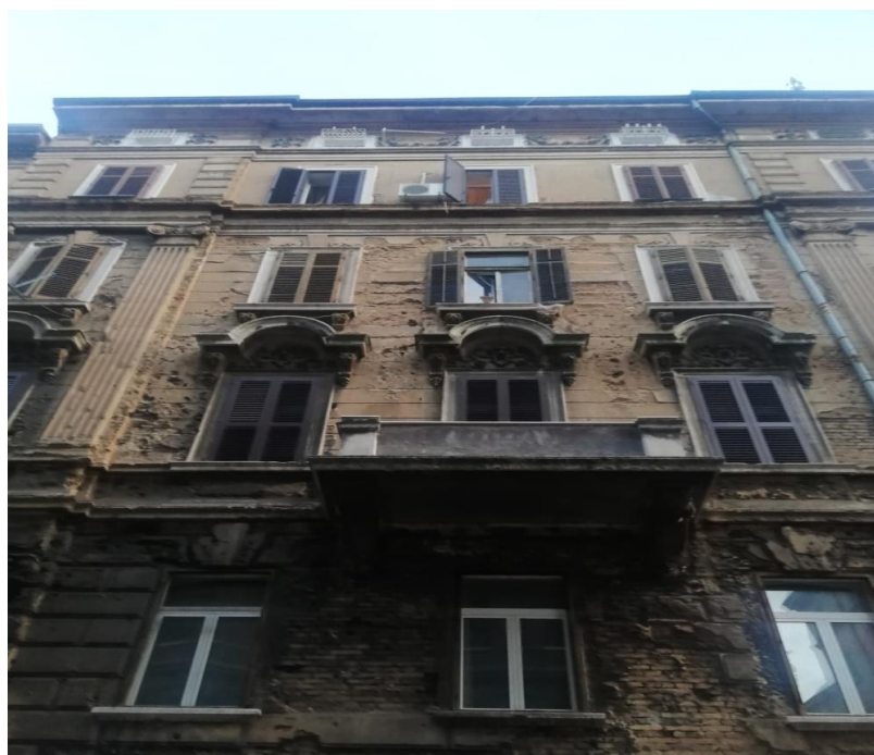
Slika 11: Sjeverno pročelje, pogled odozdo
