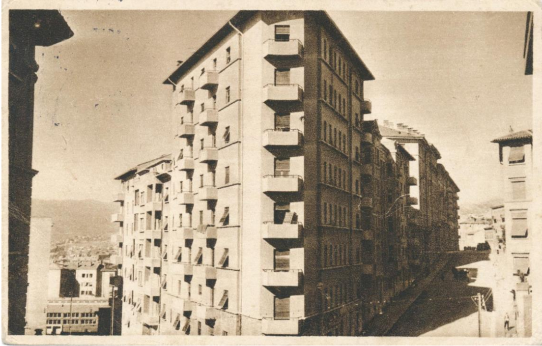
Slika 19: Istočno pročelje, Casa Nave
