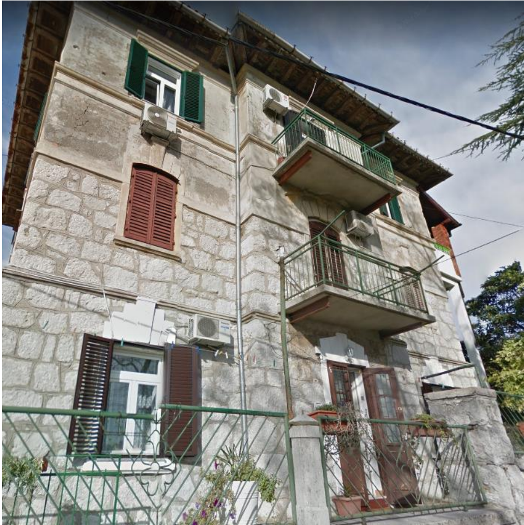
Slika 14: Južno pročelje, stvarno stanje
