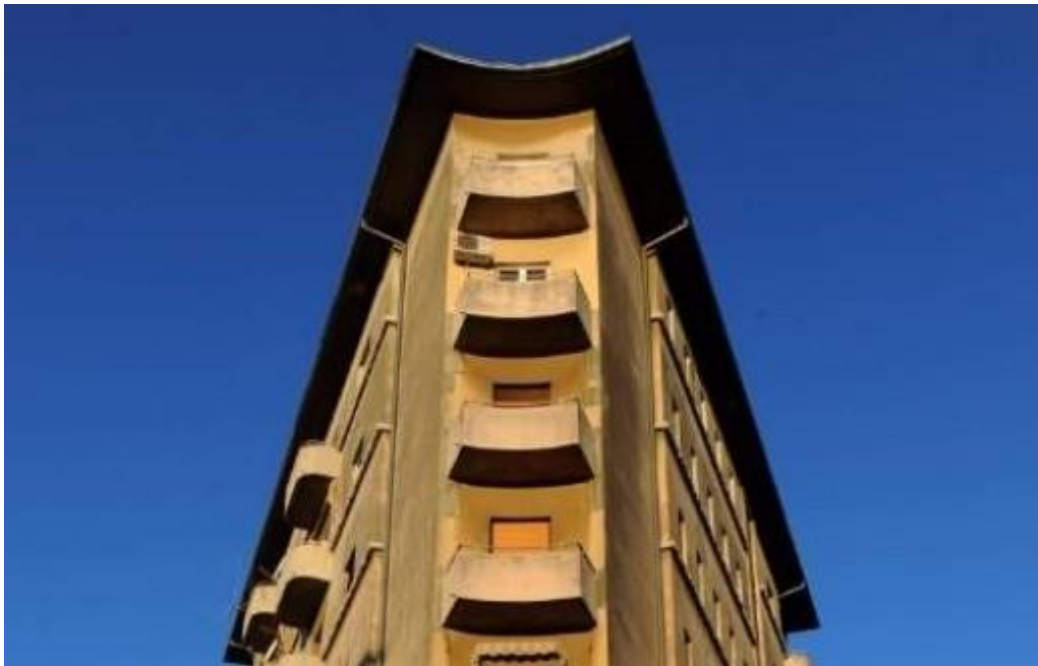
Slika 20: Istočno pročelje, Casa Nave
