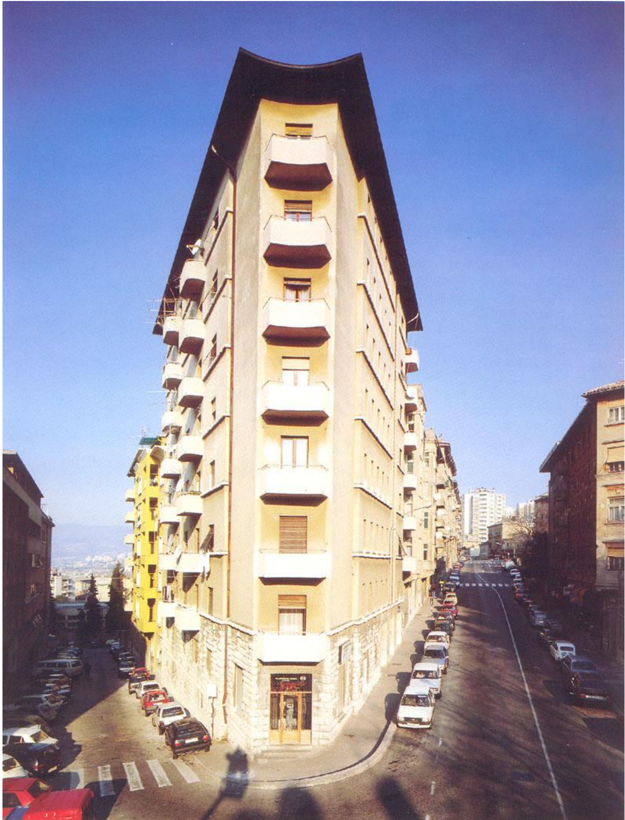
Slika 21: Istočno pročelje, Casa Nave
