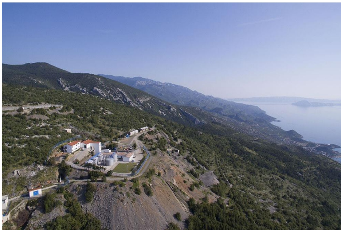
Slika 20: Postrojenje za preradu vode Hrmatine [25]
