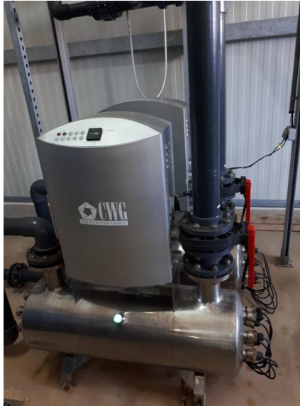
Slika 23: Uređaj za dezinfekciju putem UV zračenja [25]
