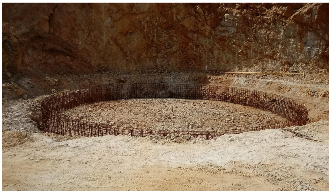
Slika 6: Armatura za betoniranje obruča (autor: Zoran Jelovac)
