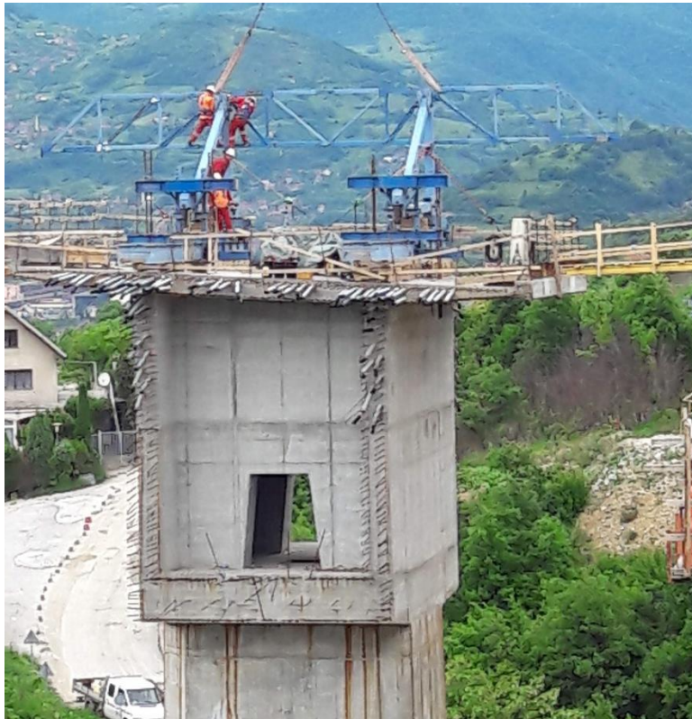
Slika 16: Nulti segment rasponske konstrukcije (autor: Kenan Zaimović)
