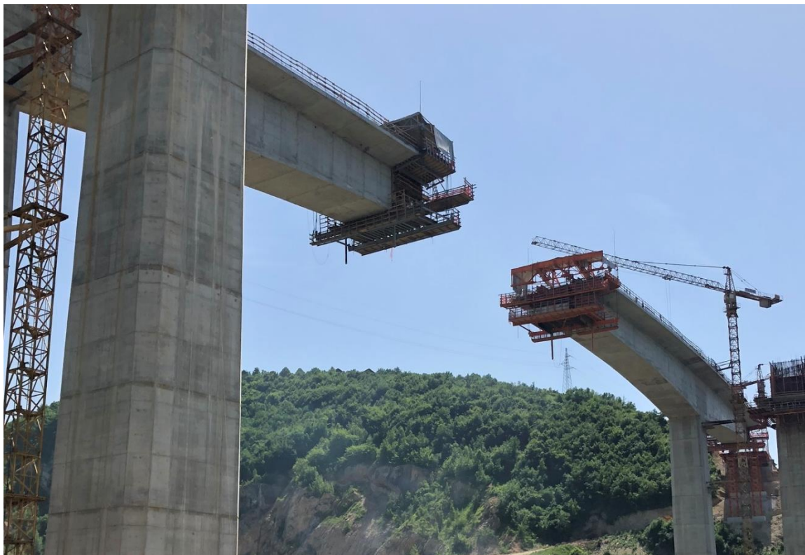
Slika 28: Izgradnja rasponske konstrukcije unutar kretke (autor: Patricia Blažević)
