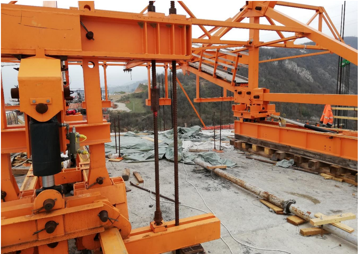
Slika 34: Glavne tračnice sa cilindrom za pomicanje krletke i vijci unutar šupljina (autor: Patricia Blažević)
