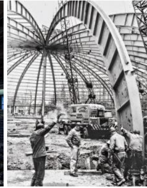
Slika 37: Postavljanje Schwedlerove kupole 1955.godine (KSi structural engineers 2014)
