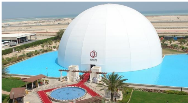
Slika 14: Prikaz napuhane kupole (Architen Landrell 219)
