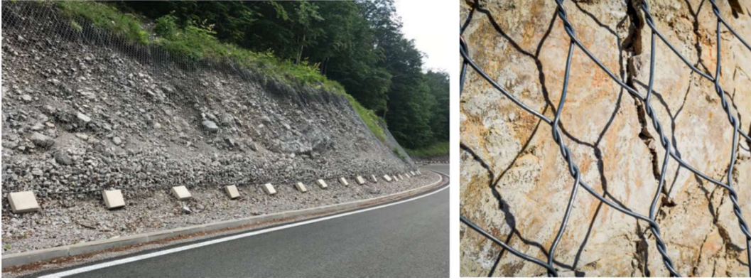
Slika 30: Zaštitna mreža učvršćena betonskim utezima [21]
