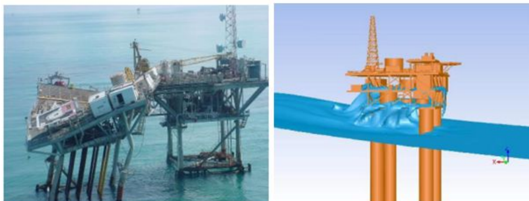
Slika 43. Simulacija velikih valova na konstrukciju platforme daleko od obale [33]
