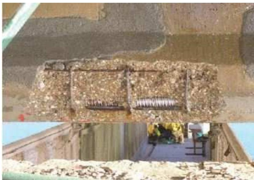
Slika 24. Izgled površine nakon uklanjanja oštećenog sloja betona [13]
