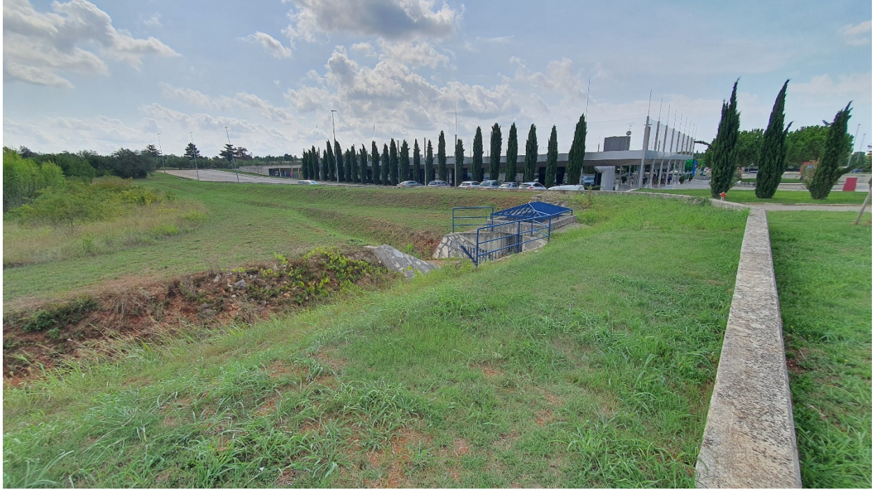
Slika 12. Pregradni zid, zaštitni nasip i kolektor u blizini dvorane
