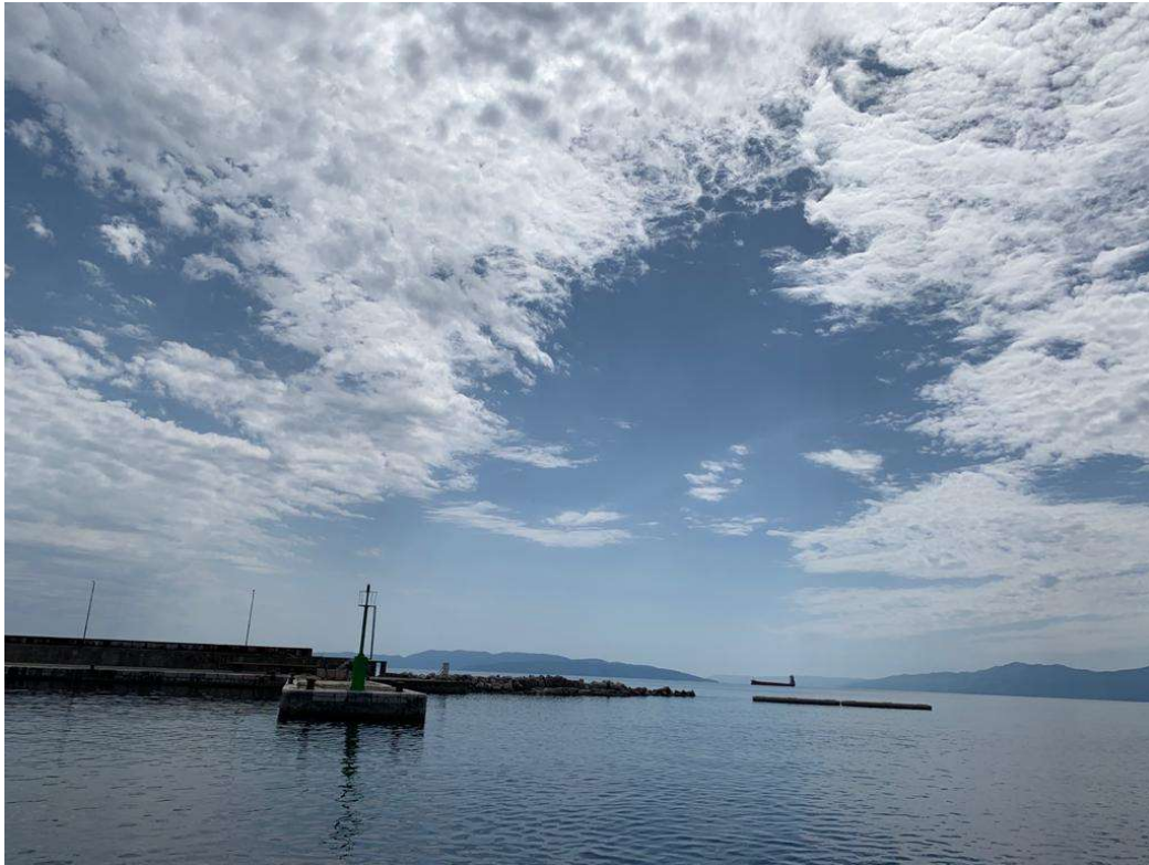
Slika 47. Pogled na neizgrađeni dio Sušackog lukobrana
