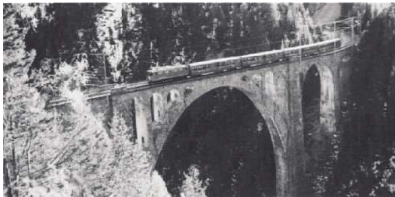
Abbildung 2.4: Wiesener Viadukt, Schweiz [2]
