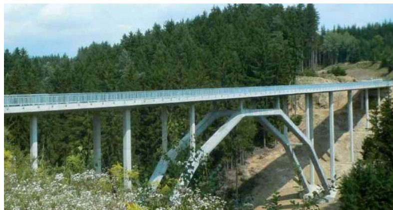
Abbildung 2.34: Ansicht der Wildbrücke [39]
