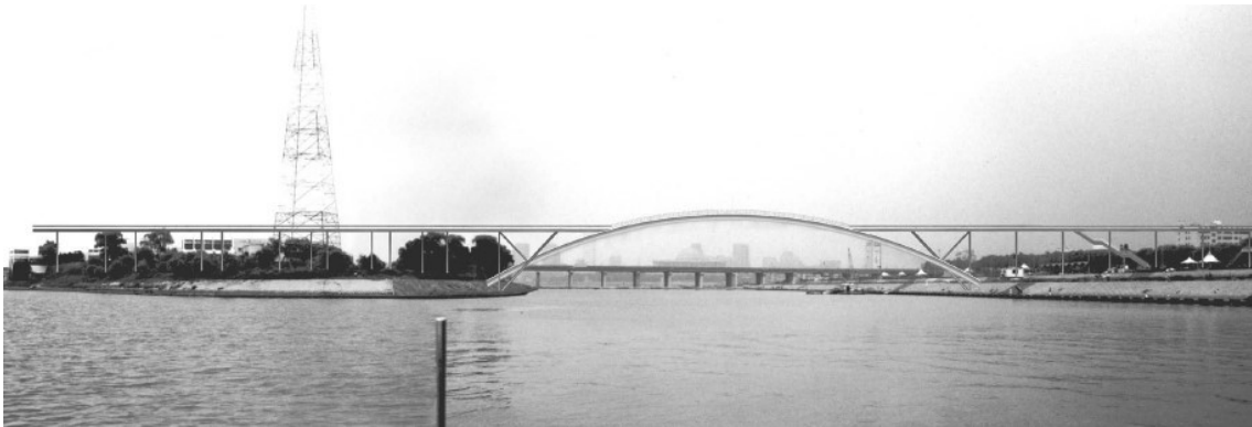
Abbildung 2.11: Gesamtansicht der Seonyu Fußgängerbrücke [13]
