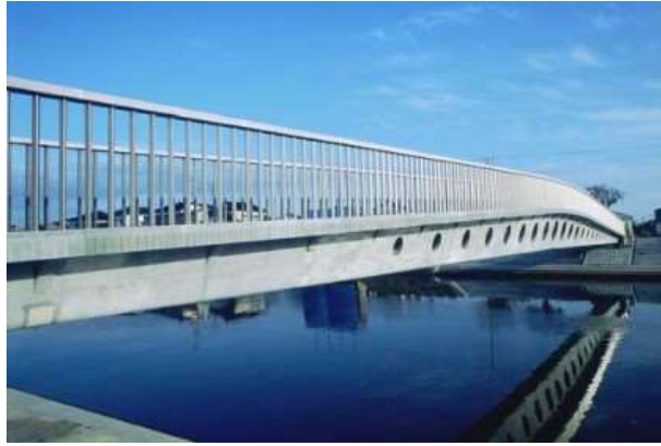
Abbildung 2.37: Sakata-Mirai Brücke, Japan [41]
