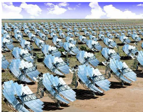
Slika 9: 2D solarna TE s paraboličnim tanjurima (izvor: https://eko.zagreb.hr/fokusiranje-sunceve-energije/88 , 2020)
