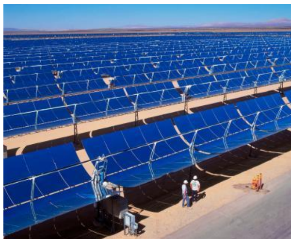
Slika 6: Parabolični paneli s protočnim medijem, Kramer Junction, California (izvor: https://eko.zagreb.hr/fokusiranje-sunceve-energije/88 , 2020)
