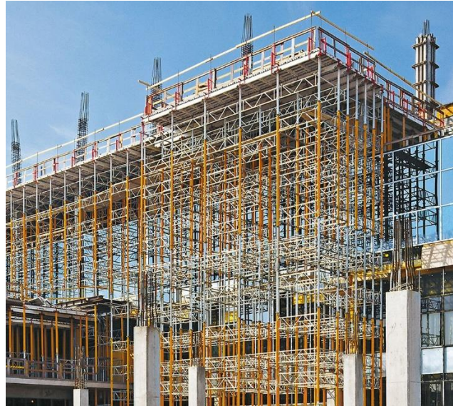
Slika 6. Primjena MULTIPROP tornja za podupiranje [3]
