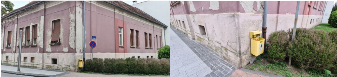
Slika 53; Zgrada pod kućnim brojem 1, slikano 12. kolovoz 2020., 15:36:52 (slika autora)
