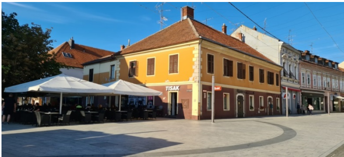
Slika 14; Stara građanska kuća, slikano 13. srpnja 2020., 18:40:13 (slika autora)
