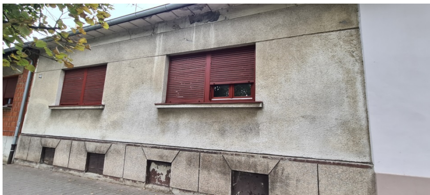
Slika 36; Kuća stara 100-150 godina, slikano 11. kolovoz 2020., 16:04:17 (slika autora)
