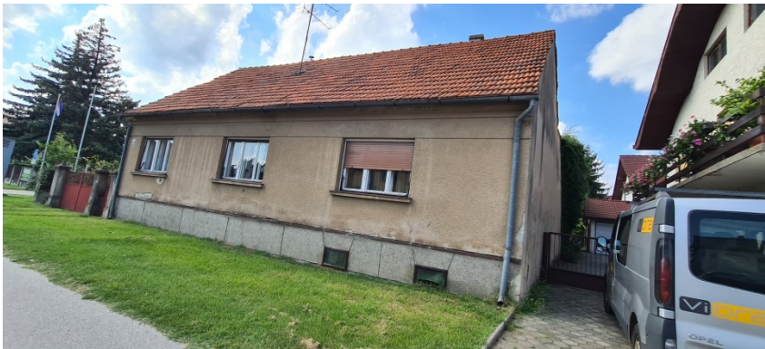
Slika 75; Stara obiteljska kuća, slikano 26. kolovoz 2020., 15:54:38 (slika autora)
