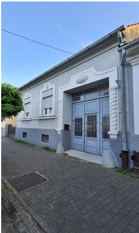
Slika 67; Prizemna građevina pod k.b. 44, slikano 15. kolovoz 2020., 15:25:06 (slika autora)
