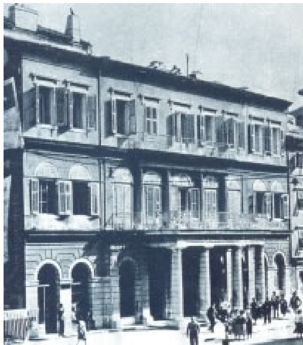
Slika 64: Zgrada Domoljubnog kazina, izgrađena 1845. godine
