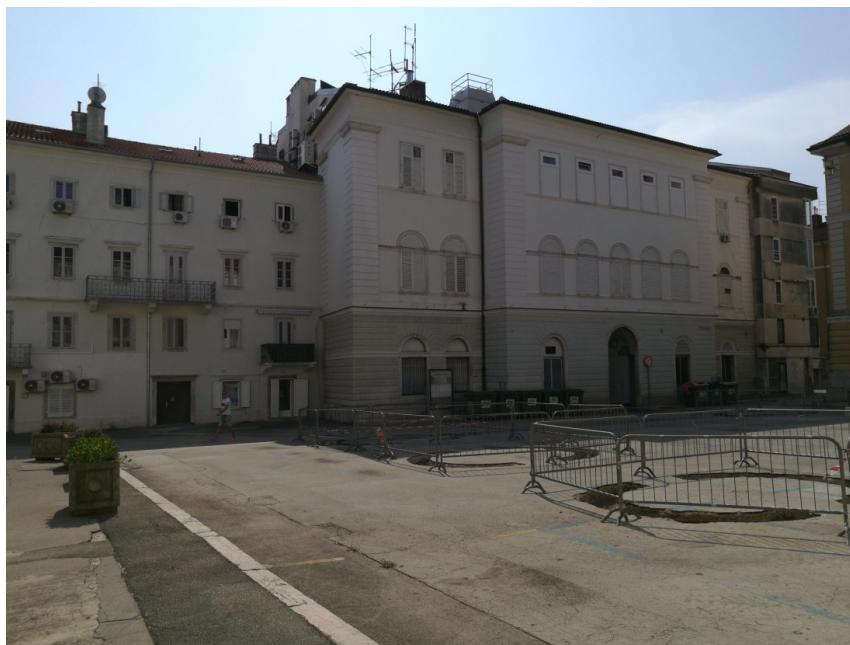
Slika 93: Južno pročelje Trga Riječke rezolucije.
