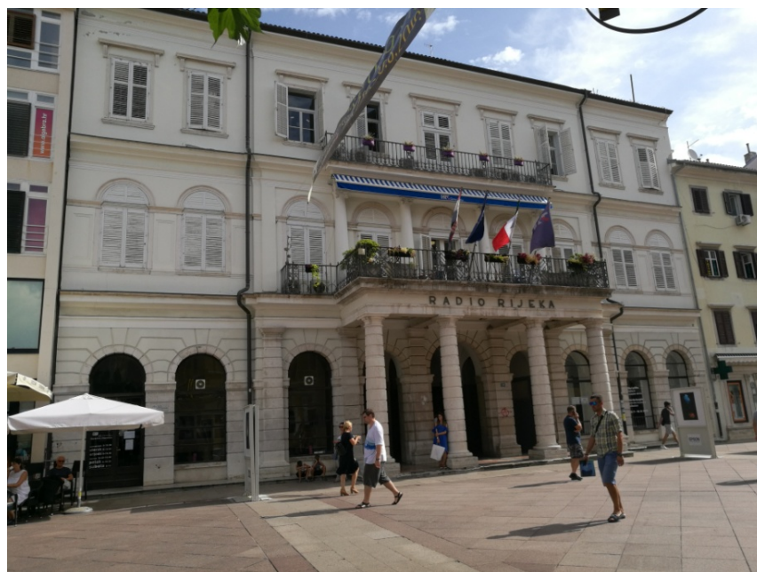
Slika 115: Zgrada Radio Rijeke, južno pročelje.
