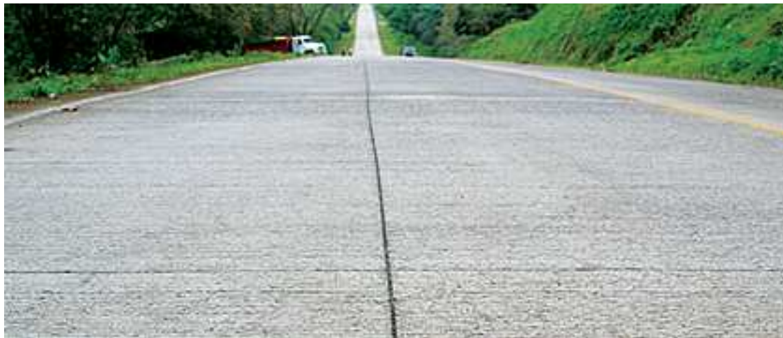
Slika 13. Kruti betonski kolnik [17]
