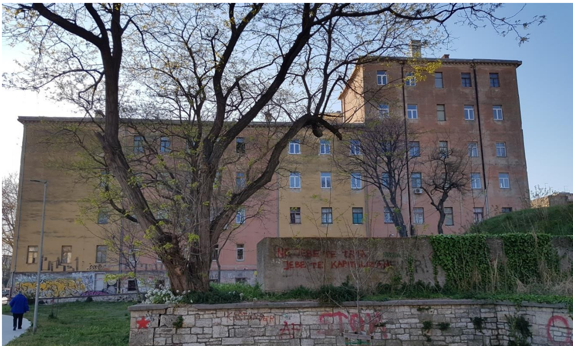
Slika 40. Istočno pročelje (Foto: autor)
